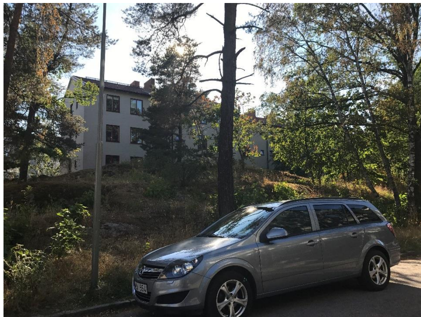
Trottoar saknas på västra sidan av Störtloppsvägen vid Skridskon 1.
