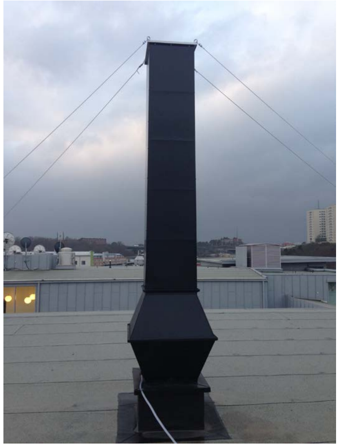
Figur 14: M26. Frånlufttorn för spiskåpa i restaurang i nordöstra delen av byggnaden. Vy västerut.
