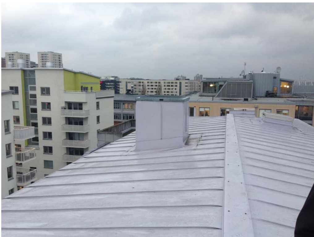
Figur 10: M24. Avluftsutblås i nordvästra delen. Vy åt nornordväst
