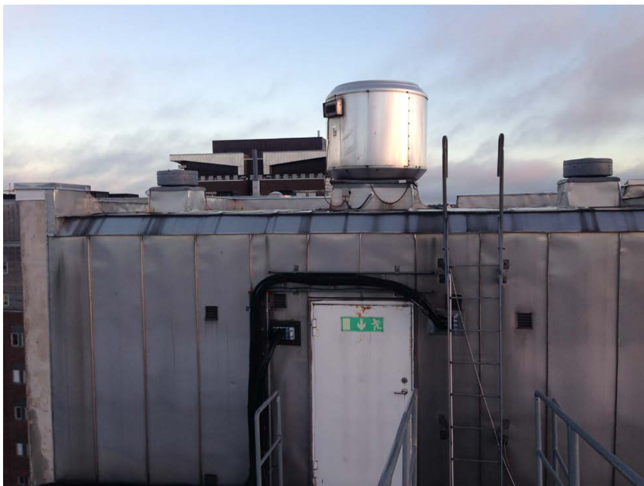
Figur 7: M23. Trapphusventilationsfläkt utifrån. Fläkten är kopplad till den mittersta av ventilationshålen, i hörnet med kablarna. Vy österut.
