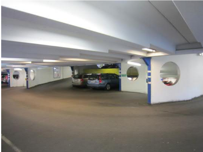
Ramper i byggnadens inre.
