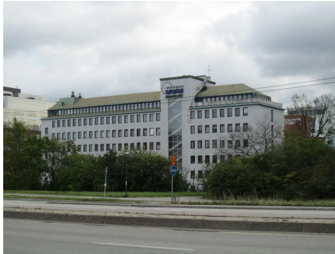
Befintlig slät fasad, uppglasat trapphus och kopparklädda takfall.
