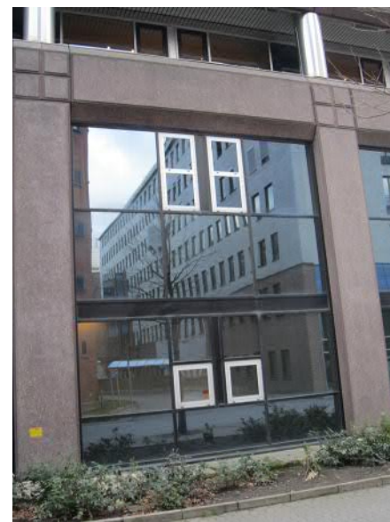
Fasadfack med aluminiumkonstruktioner.
