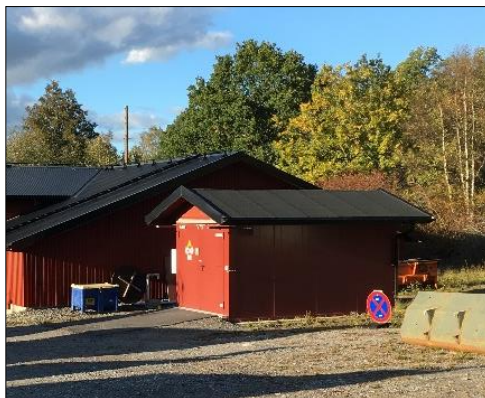
Byggnad 2, vy mot norr.
