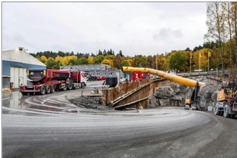
Del av Trafikverkets arbetsområde. Vy mot söder.
