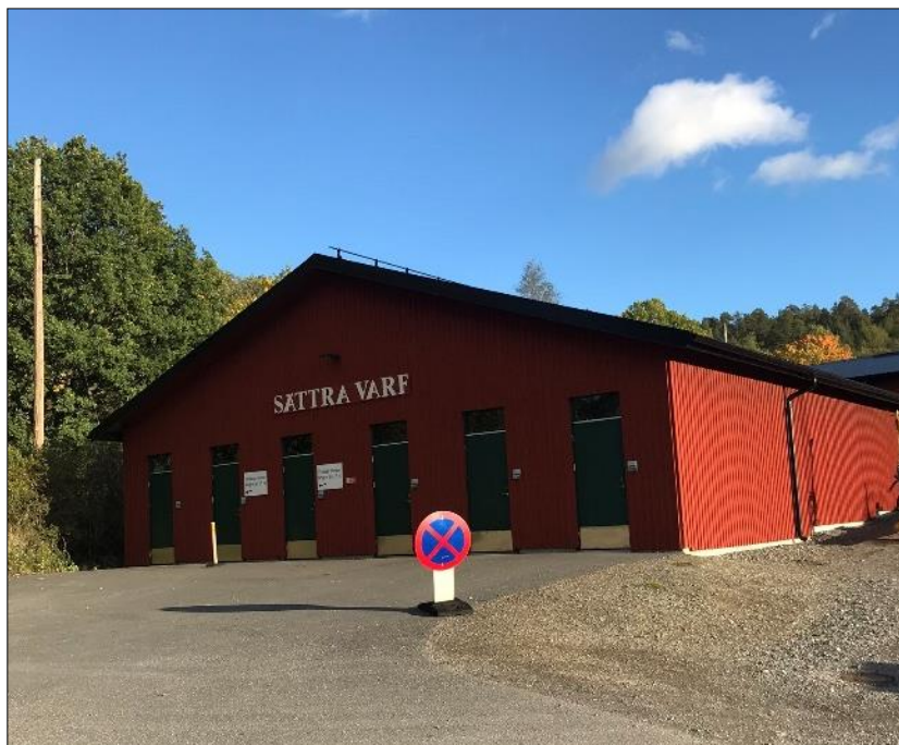
Byggnad 3, vy mot sydost.
