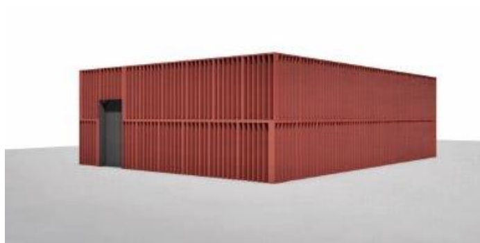
Fasadelevation samt perspektivbild som illustrerar en möjlig utformning och gestaltning av föreslagen teknikbyggnad (brandgasschakt). Bild: ON arkitekter.
