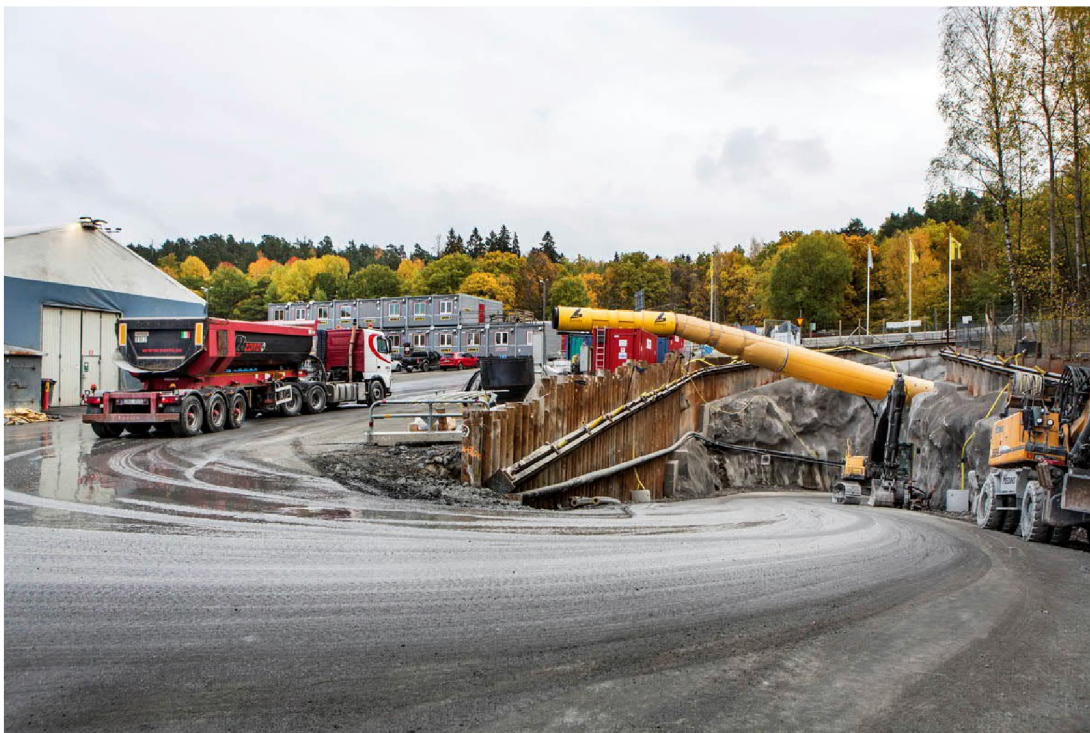
Bild 4 Arbetsområdet sedd från norr mot söder med försärningen/rampen till höger i bild. Asfalt och byggnader är uppbyggda ovanpå befintlig hamnplan. Ytan har inte varit asfalterad tidigare.
