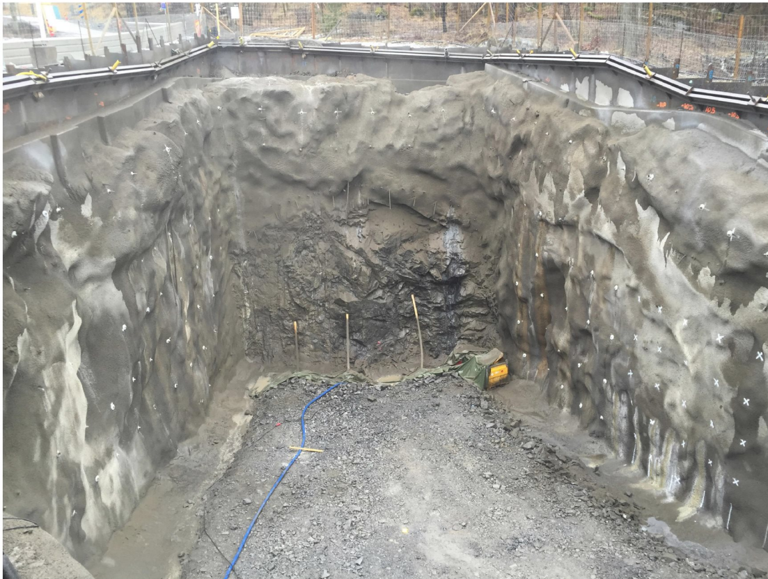
Bild 3. Försärningen blev klar 2016. Bilden visar den djupaste delen där arbetena med bergtunnlarna påbörjades (rakt fram i bild).
