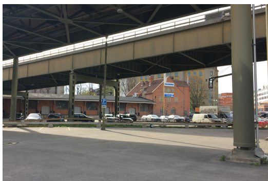
BILD 38: UNDER LILJEHOLMSBRON FINNS ÖDE PARKERING OCH GAMLA TÅGSTALLAR. FOTO JORUNN RÅDBERG/SWECO
