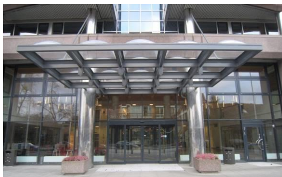
Pelare klädda i rostfri plåt
