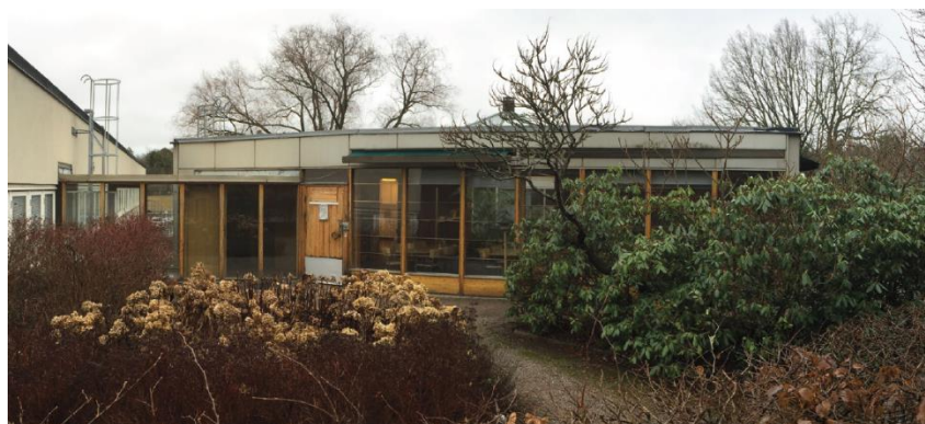
Paviljongbyggnad som avses bevaras centralt i Vitsandsparken. Byggnaden är idag sammanlänkad med en lågdal, till vänster i bilden, som föreslås rivas.
