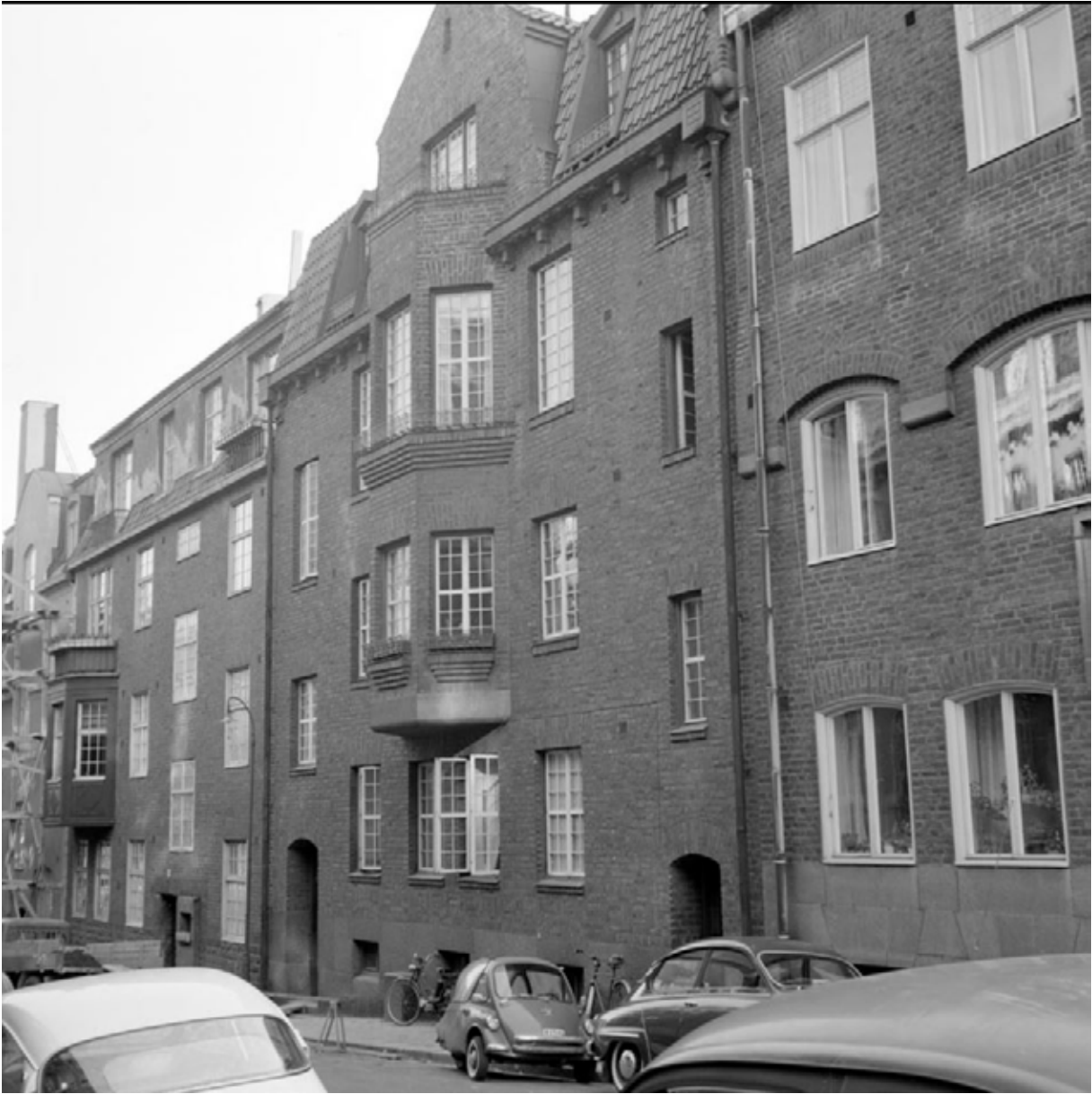
Sköldungagatan 6 fotograferat 1966, bild från Stockholms stadsmuseum. Notera att fönstersättningen där man ser att de yttre fönsteraxlarna som betjänar trapphusen ligger förskjutna i förhållande till mittpartiet och till varandra.
