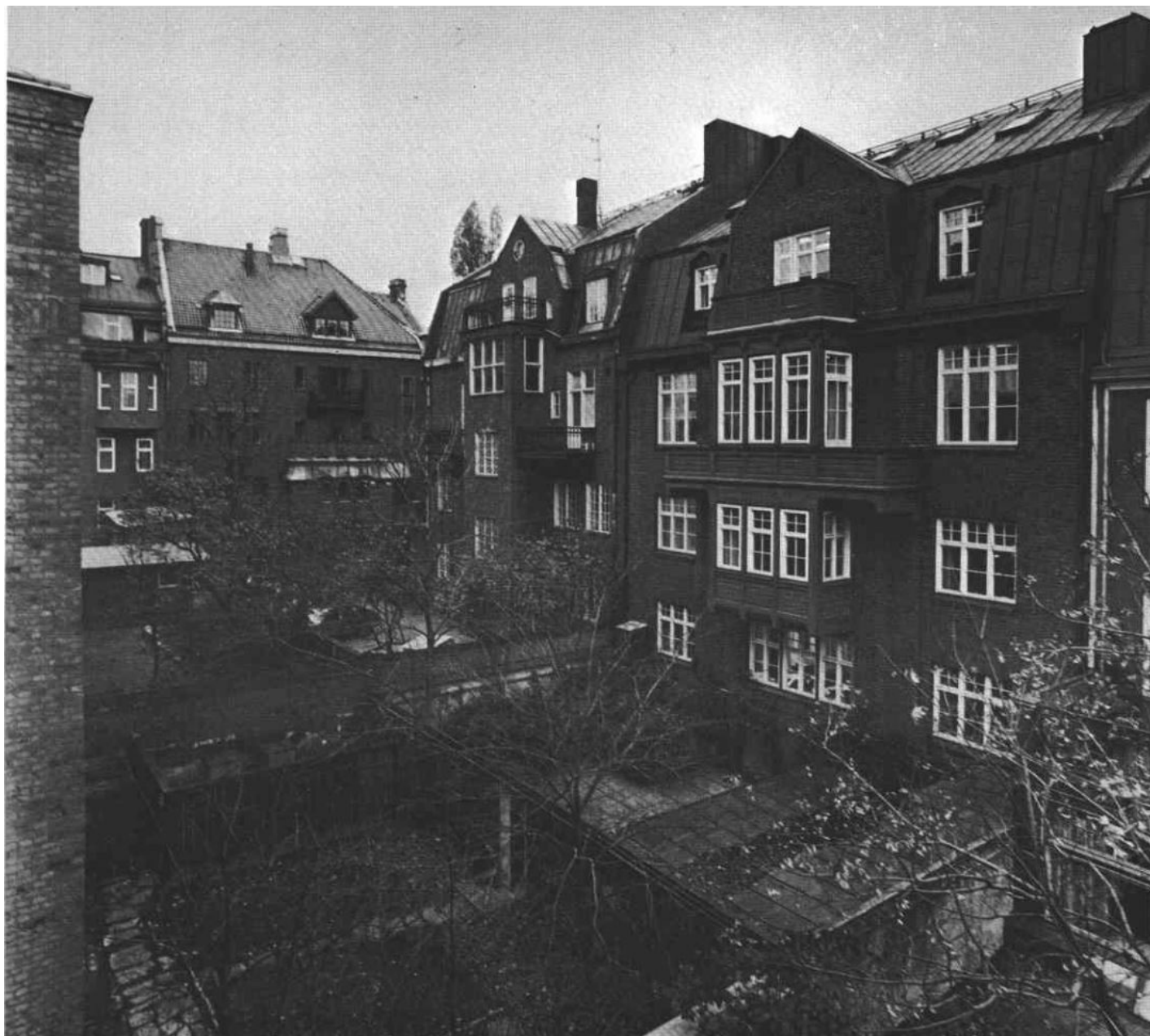
Gårdrummet med Sköldungagatan 4 och 6 fotograferat ca år 1977, ur boken Malmö från Stockholms stadsmuseum
