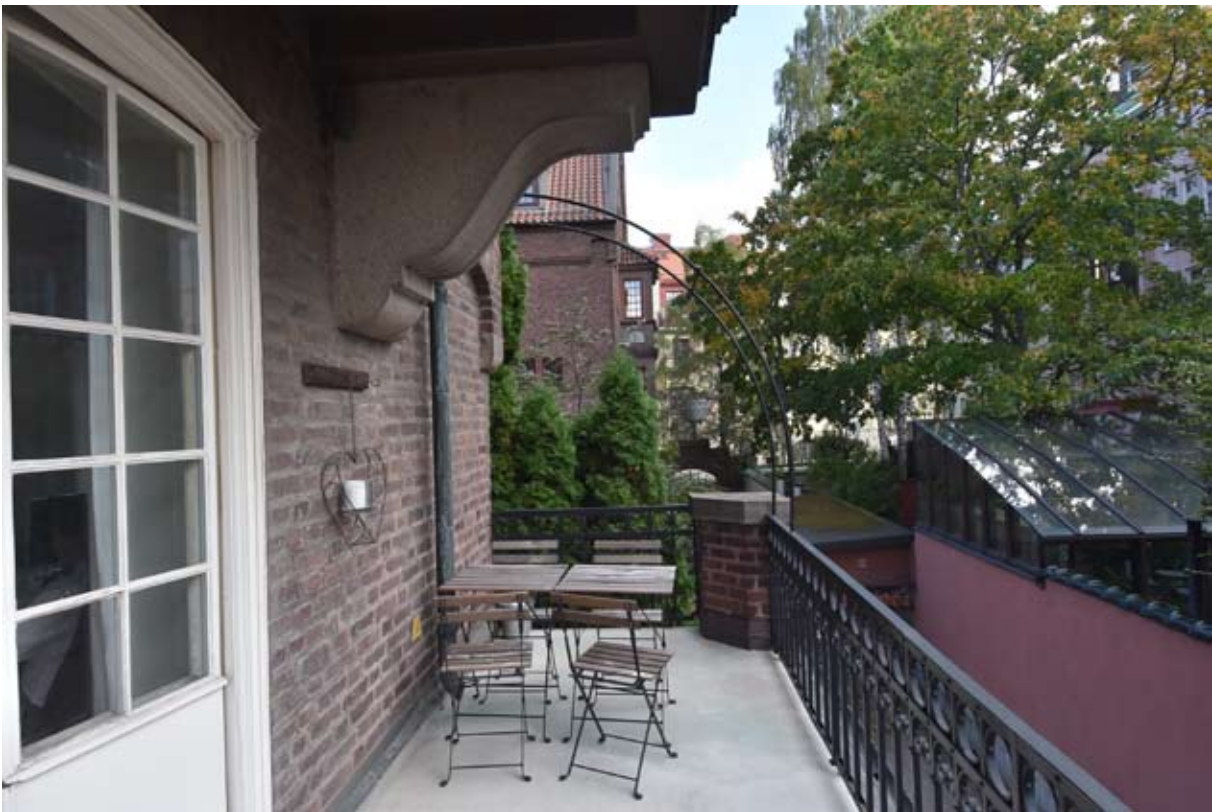
Balkongterrass, notera konsolen i granit.
