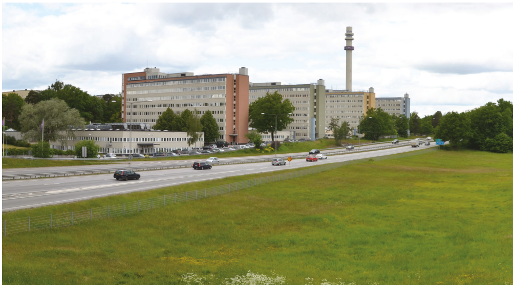
Vy 3 - från Nynäsvägens dalgång, befintlig situation
