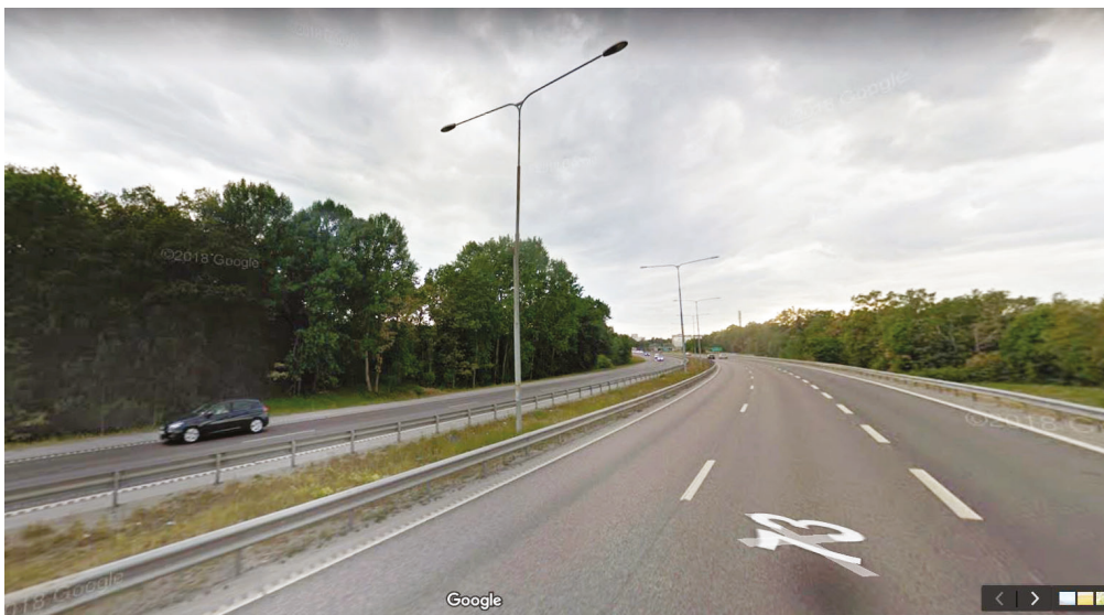
Vy 7 - från Nynäsvägens dalgång, befintlig situation
