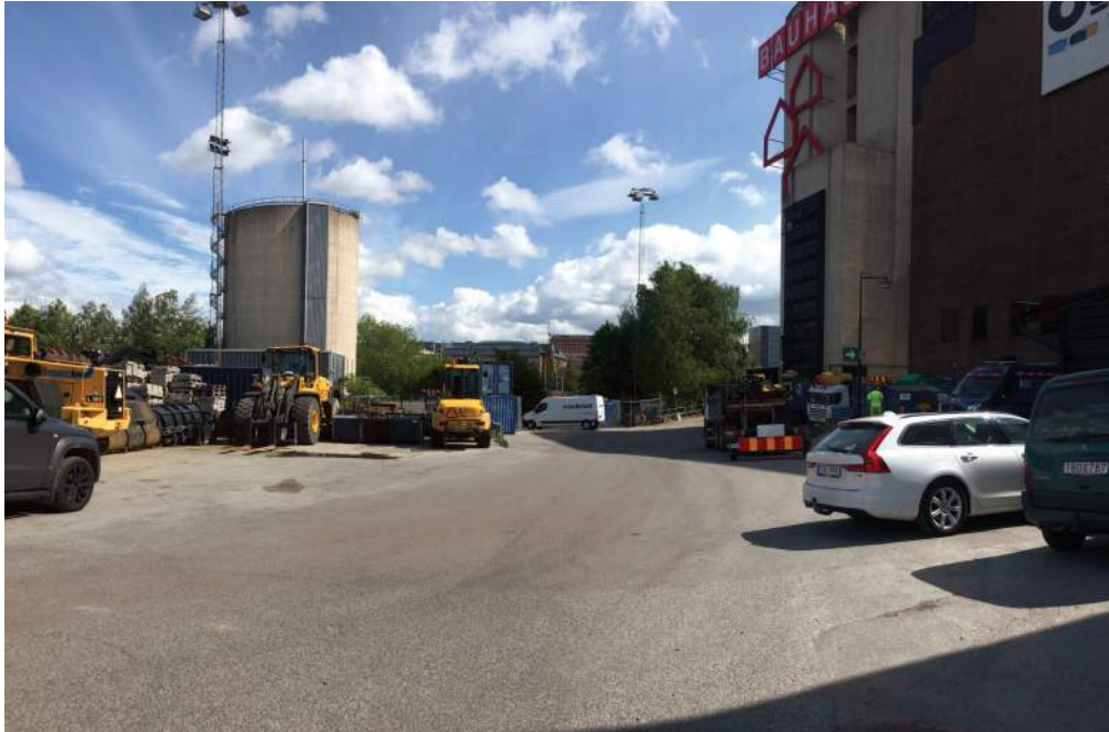
Vy 6 - längs Triangelplatsen mot vattnet, befintlig situation
