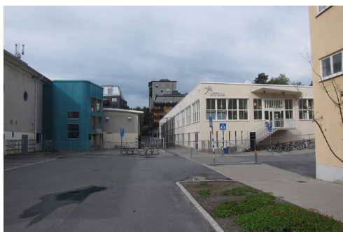
Figur 1. Del av planområdet med byggnad för Vittraskolans årskurs 7-9 t.v. i bild. Foto: Ramboll.
