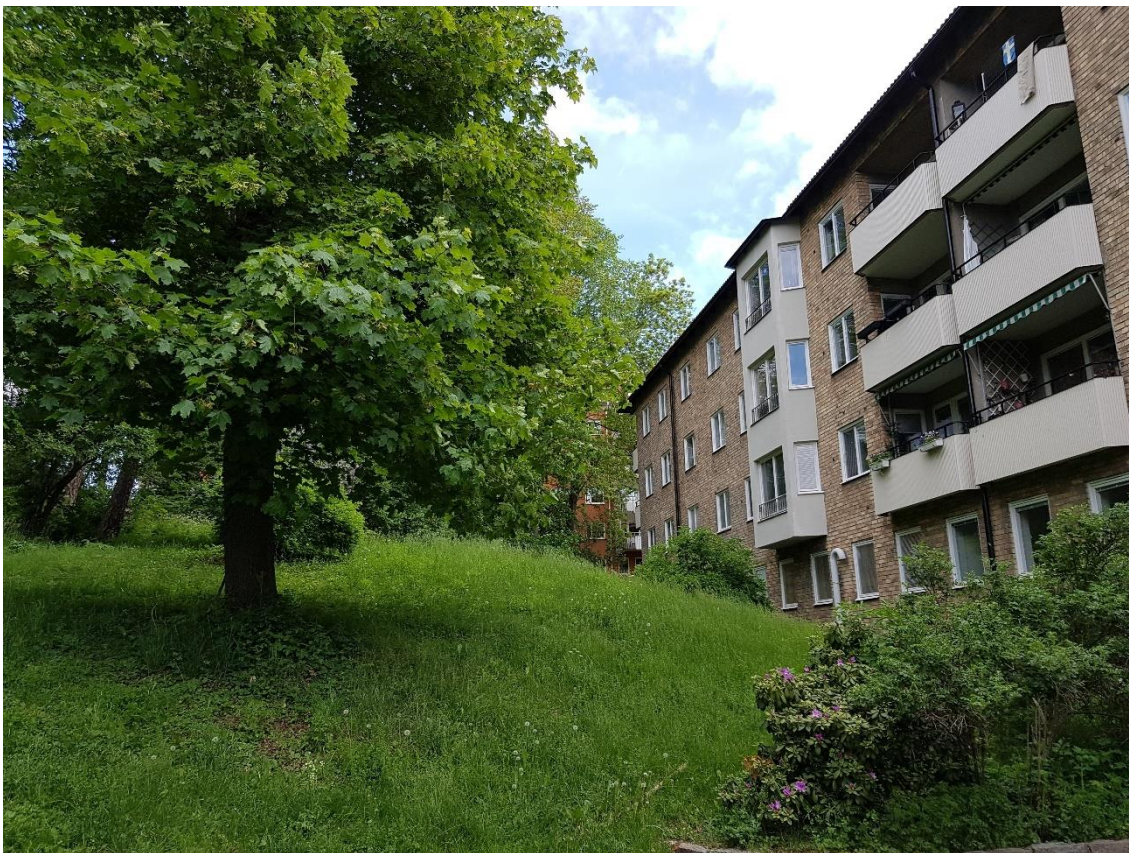
Figur 13 Kv. Genua 1 foto taget från fastighetens sydvästra hörn upp mot bef. Byggnad.
