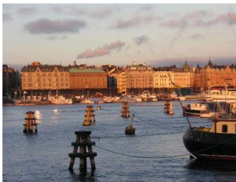
Dykdalber, påkörningsskydd i Nybroviken, Stockholm.
