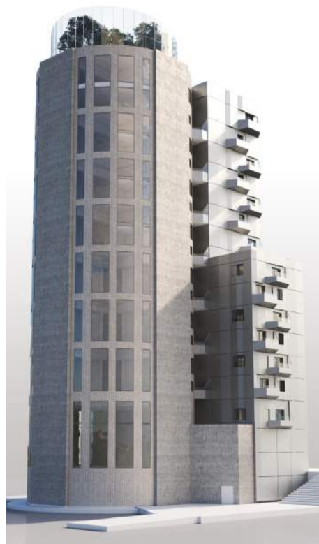
Illustration. Norra silosen. Fasaden av befintlig betong isoleras och putsas i en neutral ljusgrå cementputs.
