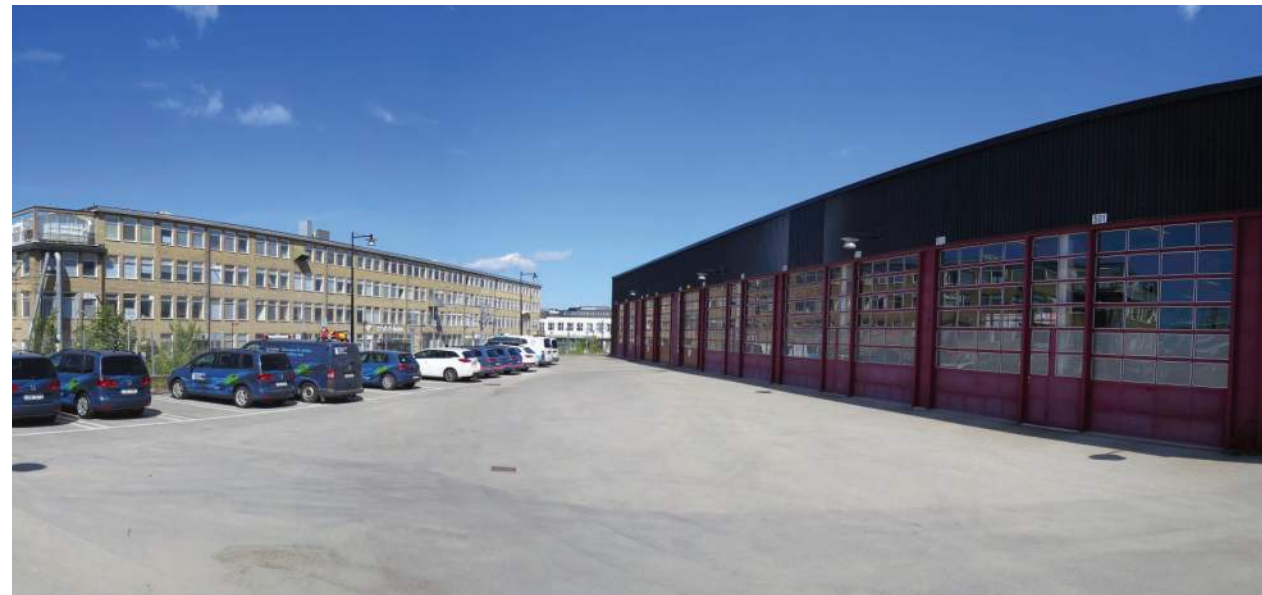
Körtyta framför verkstadsbyggnaden (15).
