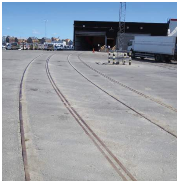
Vy längs järnvägsspåren in i lastningshallarna (21-24).
