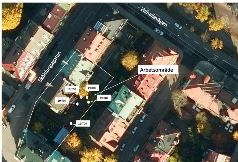
Figur 3 Ortofoto över undersökt område i streckat röd markering, fastighetsgräns i vit markering samt markerade punkter för miljöprovtagning. (eniro.se)
