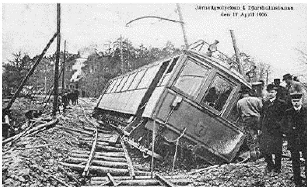
Figur 14. Urspårning på Djursholmsbanan den 17 April 1906. Trots att urspårningen var omfattande blev det primära skadeområdet endast begränsat till spårets omedelbara närhet.
