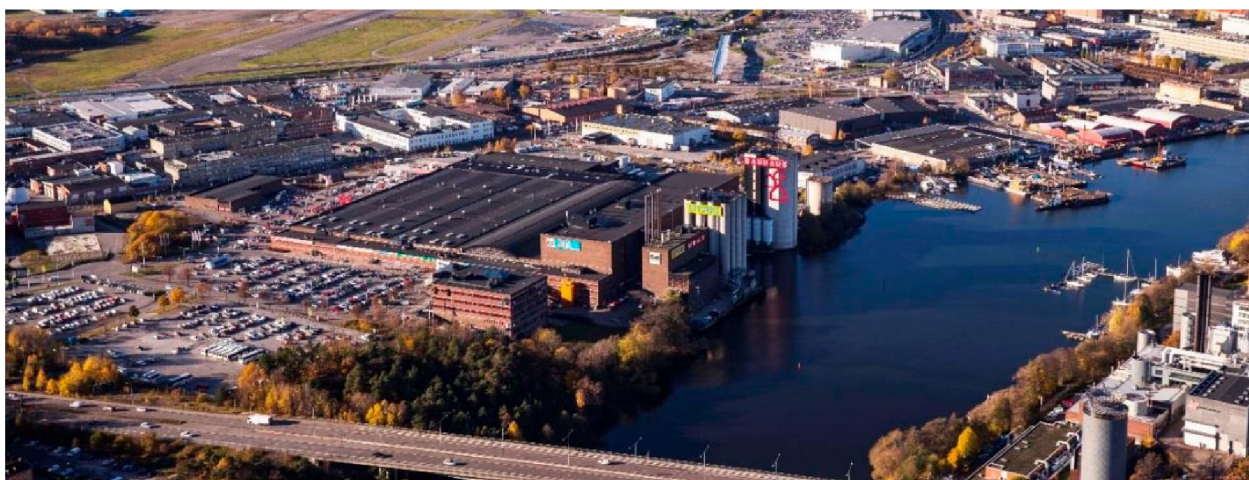
Figur 2. Flygbild över Planområdet. Ulvsunda industriområde centralt i bilden, Bromma flygplats och Bromma Blocks i den övre delen av bilden, Huvudstabron i nederkant.
