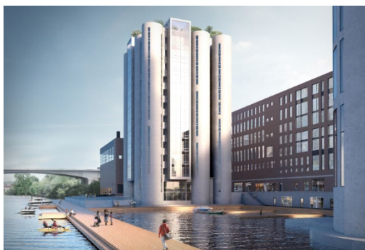
Den södra silosens rör utformas med vertikala fönsterslitsar som löper över flera våningar. Den norra silosens rektangulära del ges kontrasterande gestaltning för att hantera buller och mikroklimat.
