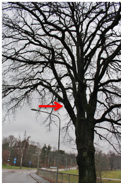
Bild 5 Den rötskadade grenen
