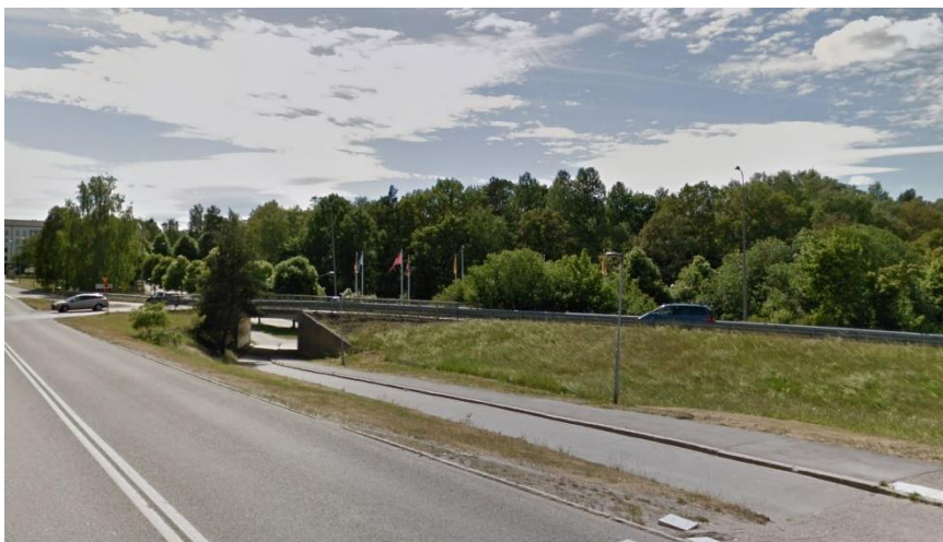
Figur 3. Planskild gång- och cykeltunnel under avfart från Nynäsvägen till Ågesta Broväg. Bildkälla: Google maps, hämtad 2019.
