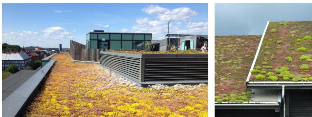
Figur 27. Exempel på olika typer av gröna tak, med en takträdgård till vänster och ett tunnare grönt tak till höger. Bild hämtad från Stockholm Vatten och Avfalls anläggningsbeskrivning för vegetationsklädda tak.
