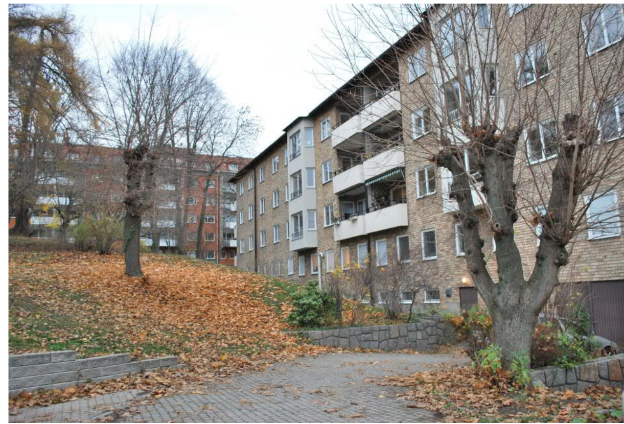
Gårdsfasaden har utöver de två burspråken även försetts med indragna balkonger centrerade på fasaden. Mot den hårdgjorda delen av gården ansluter kuperad naturmark och stora träd. Ursprunglig gårdsstruktur finns delvis bevarad i form av naturstensmurar och lövträd. Ett flertal hamlade träd finns i och omkring gårdsytan.
