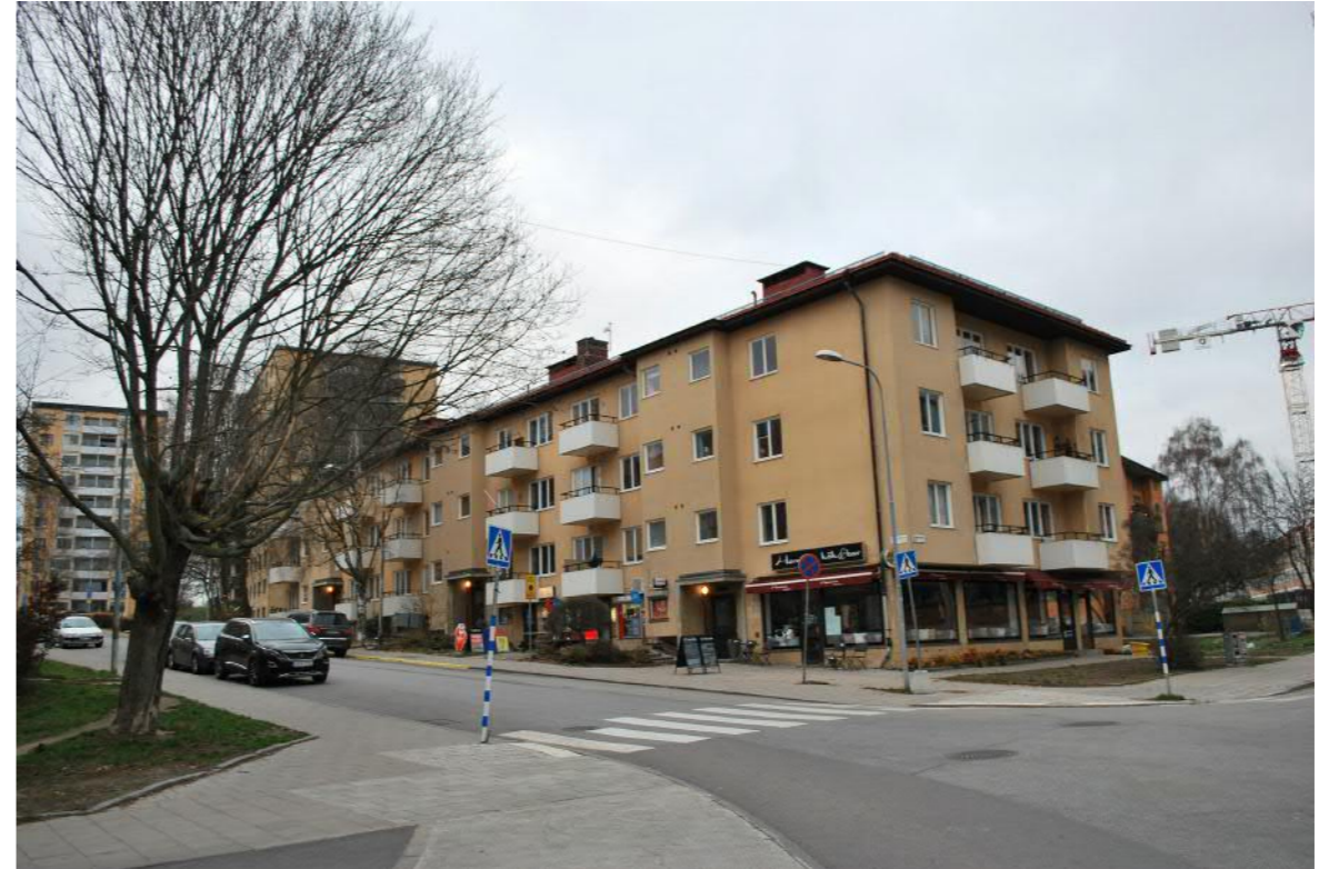
London 5 ritad av arkitekten Björn Hedvall har en mer lekfull utformning än Genua, med större fönstervariation och entréer placerade indragna i burspråkens hörn. Bottenvåningens södra del utgörs idag av en restaurang med uteservering mot Östhammarsgatan.
