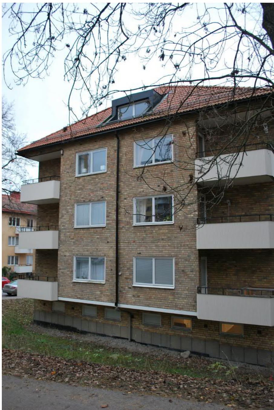
Balkongerna har korrugerade plåtfronter med avfasade hörn och överliggare i smide.
