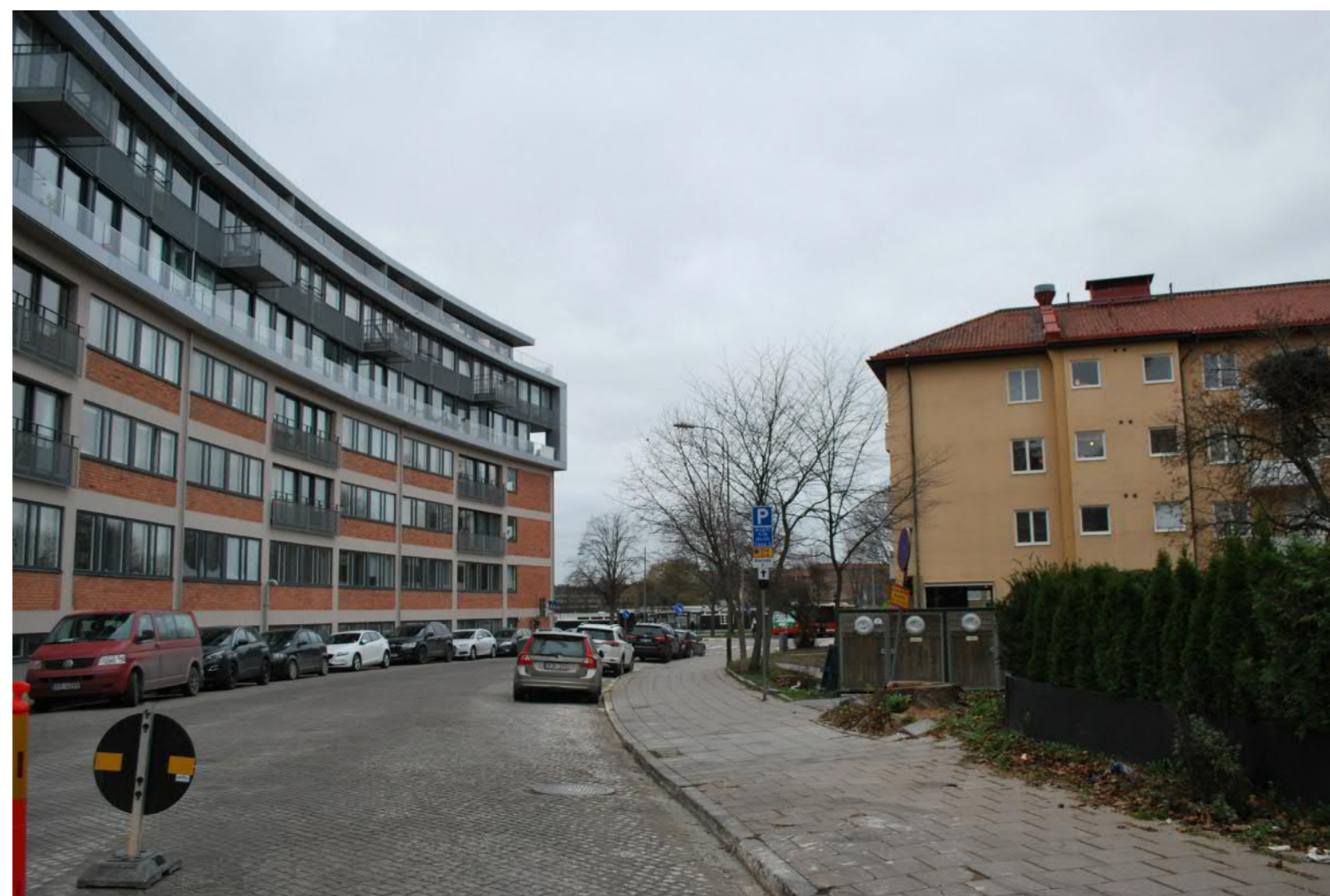
Längs med Östhammarsgatans södra sida sträcker sig den före detta kontors- och lagerbyggnaden inom Tegeludden 3 som påbyggs i samband med konverteringen till bostäder. Kvarteret Genua döljs bakom lamellhuset i kvarteret London.
