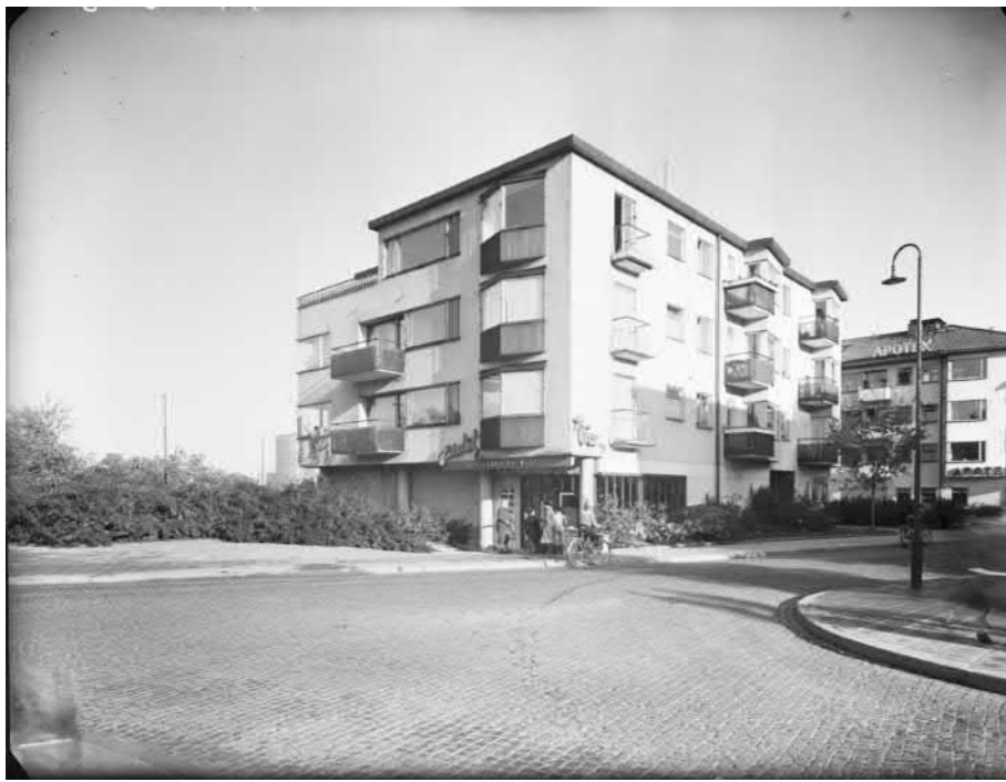
Flerbostadshus med butiker i gatuplan, Gärdet Livs "Det glada kalaset". Arkitekt Sture Frölén. Foto Sune Sundahl, ArkDes/Digitalt Museum.
