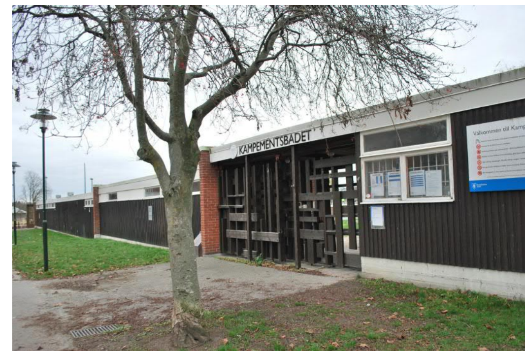
Entré till Kampementsbadet.
