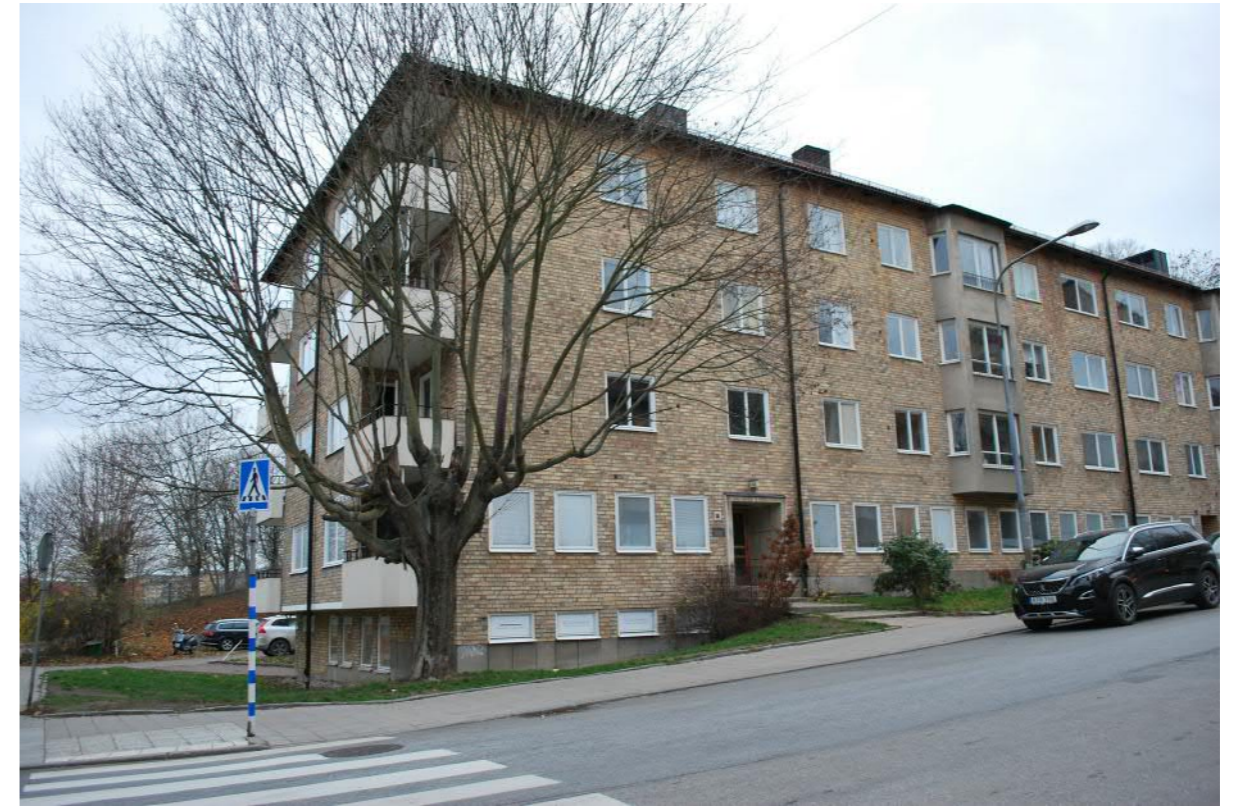
Halvsutterräng mot söder. Sutterrängväningen är indragen vid gavelfasaden.
