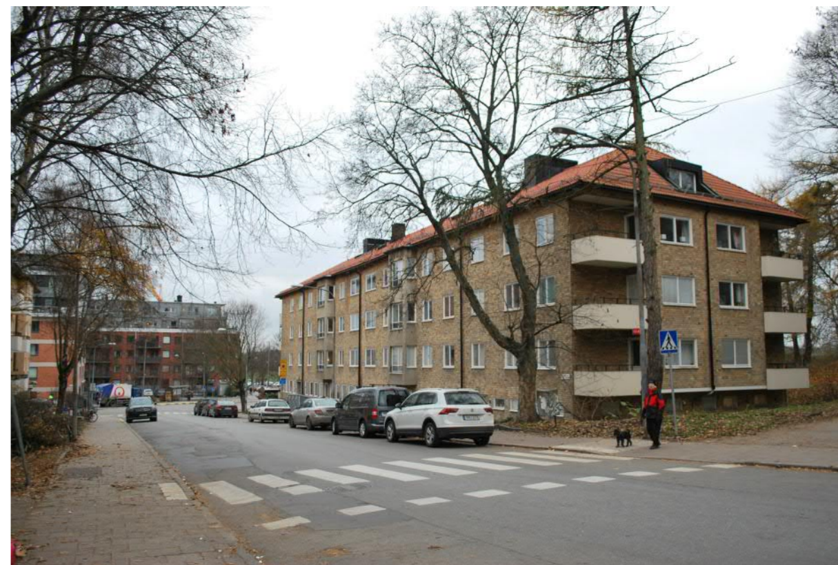
Den långa fasaden mot Sandhamnsgatan vars höjd tonas ner för slutningen. Gavlarna har lika utformning på båda sidor med framträdande mittparti, indragna hörnbalkonger och valmat tak med takkupa.
