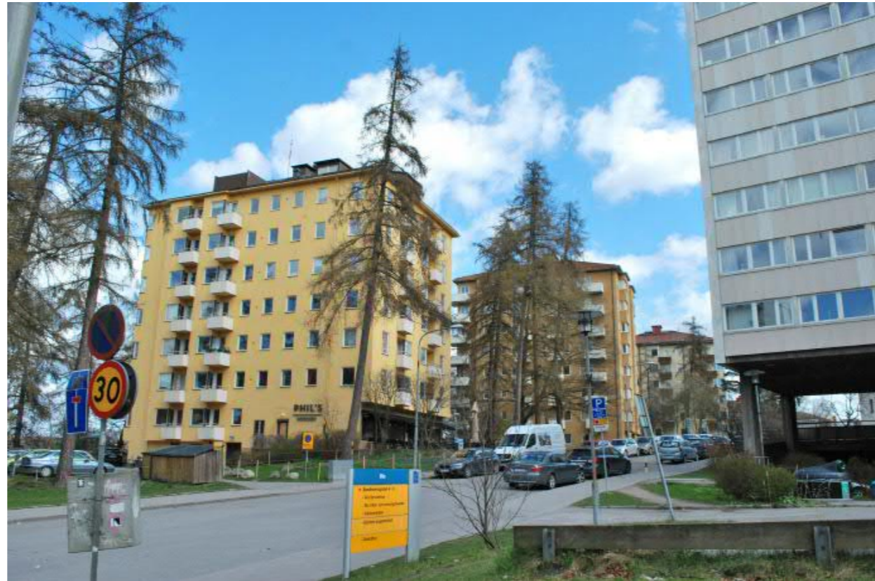
Sandhamnsplanens norra del som ansluter till Värtavägen. Punkthusen i kvarteret New York uppfördes under 1940-talet. På en obebyggda delen av New York 1 tillkommer ytterligare ett bostadshus på 8-9 våningsplan inom kort. Till höger skimtar studentbostadshuset Fyrtalet från 1967, ritat av Leonie Geisendorf.
