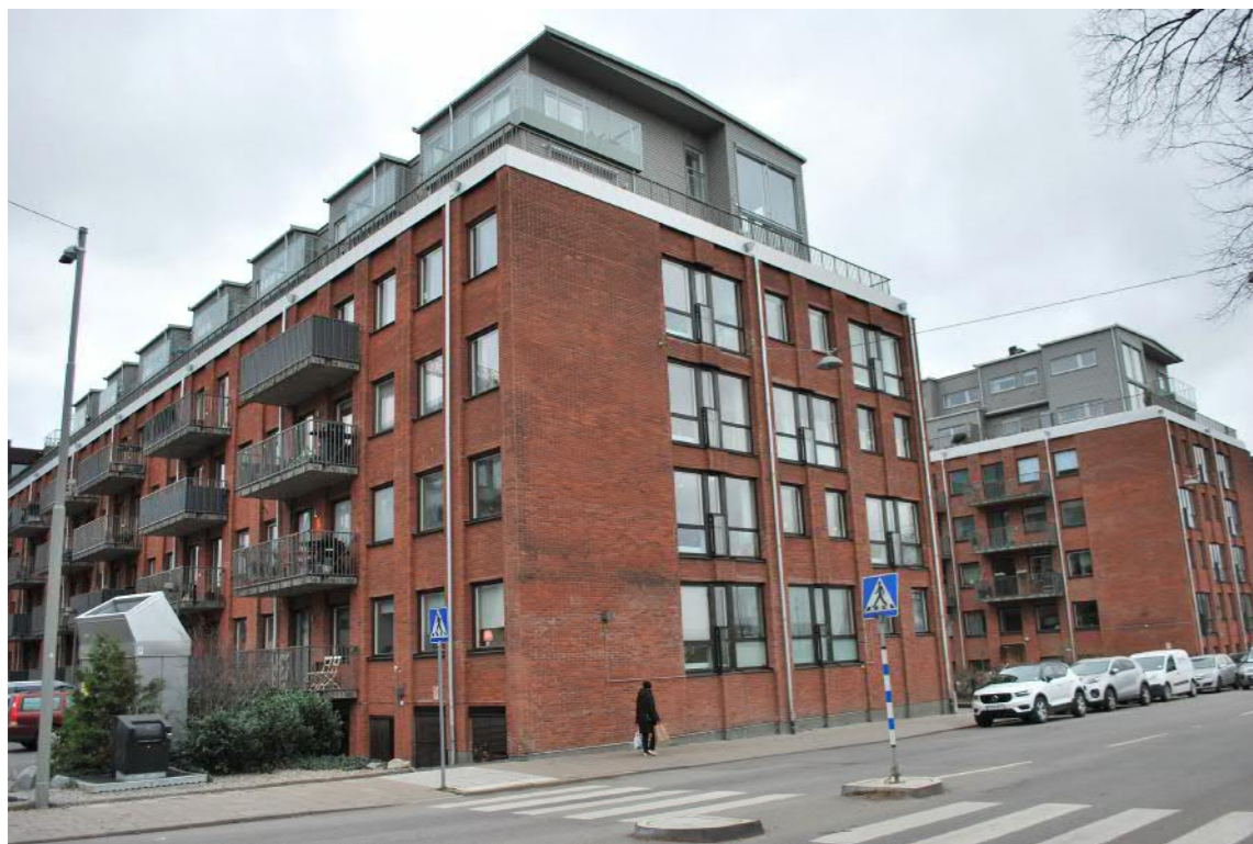
Tegeludden 11 uppfördes som kontorshus 1961 men omvandlades till bostäder 2010 och byggdes på med två våningar. Påbyggnaderna har fasader i grå plåt och har placerats indragna från övrig fasad.
