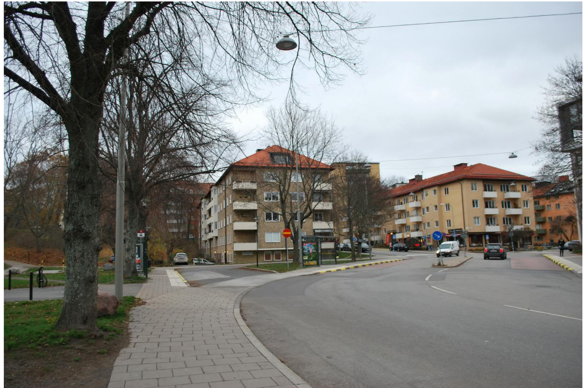
Genua utgör en tydlig bebyggelsefront mot Sandhamnsgatan söderifrån. Söder om Genua vid korsningen Sandhamnsgatan-Östhammargatan finns en platsbildning i form av en hållplats/väntplats för bussar med ett gräsbevuxet impediment med två högväxta lövträd mot trottoaren.
