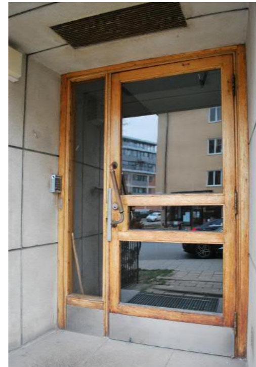
Mot Sandhamnsgatan finns två entréportar till trapphusen som har ursprungliga glasade ekdörrar med sidoljus och tidstypisk beslagning.
