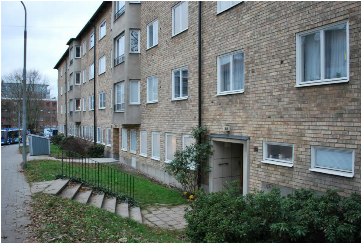
Förgårdsmark mellan byggnaden och trottoaren längs Sandhamnsgatan. Nivåskillnaden i norra delen överbyggs med trappor i granit med ursprungligt smidesräcke. Framför entrén finns markbeläggning av granitplattor.
