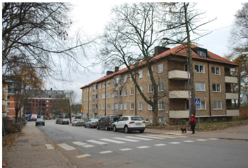
Befintlig byggnad sedd från Sandhammsgatan i nordost.
