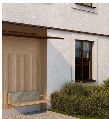
Sockelvåningen markeras med en plåtlist i samma kulör som övriga plåtdetaljer. Fönster i sockelvåning är högre än på övriga våningsplan. Referensbild White.
