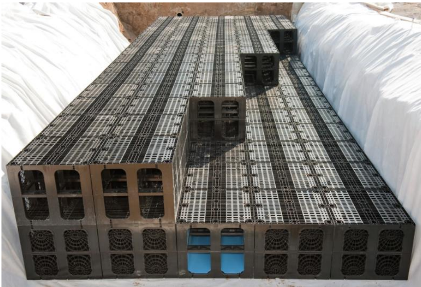
Figur 17. Exempelbild på dagvattenkassetter och dess konstruktion.
