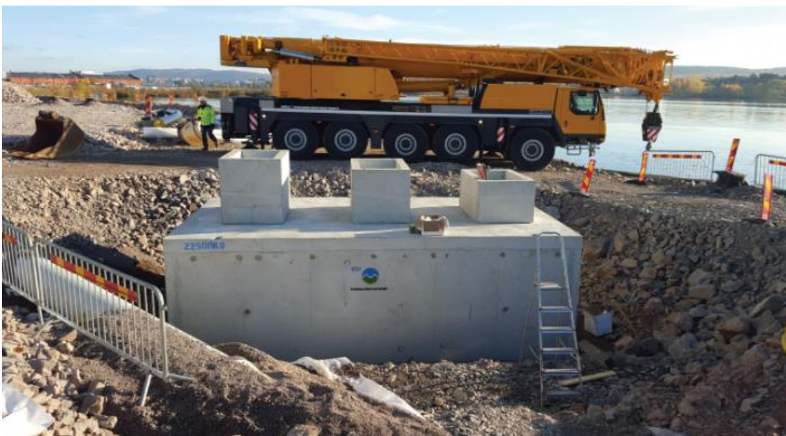
Figur 18. Exempelbild på Ecovault dagvattenmagasin. Bild från: Seka Miljöteknik AB.
