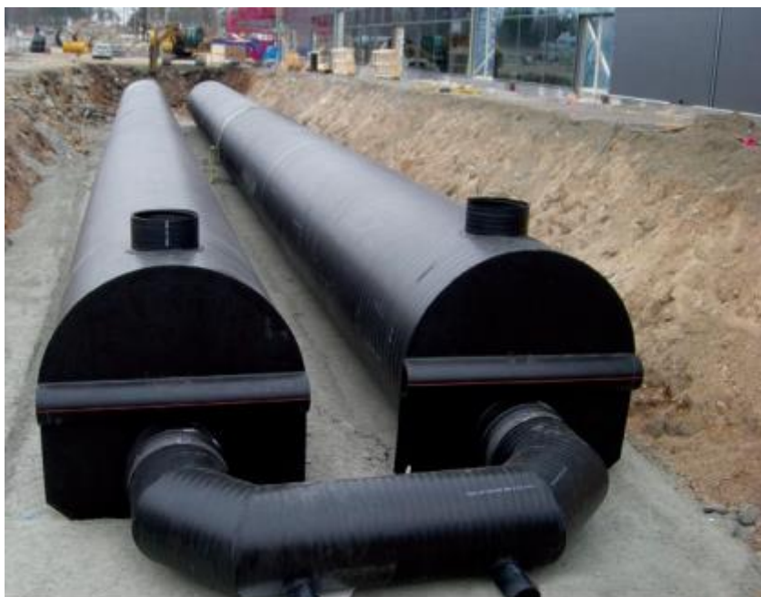
Figur 13. Inspirationsbild: Parallellkopplat rörmagasin från Växjö (Uponor).
