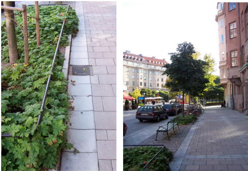
Figur 23. Vänstra bilden visar en vanlig rännstensbrunn som leds till skelettjorden intill. Högra bilden visar träd planerade i skelettjord på Erik Dahlbergs allé (Bildkälla: Stockholm vatten och avfall)
