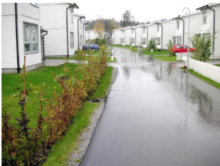
Figur 17. Makadamdike mellan lokal gata och tomtmark. (Bildkälla: Stockholm vatten och avfall)
