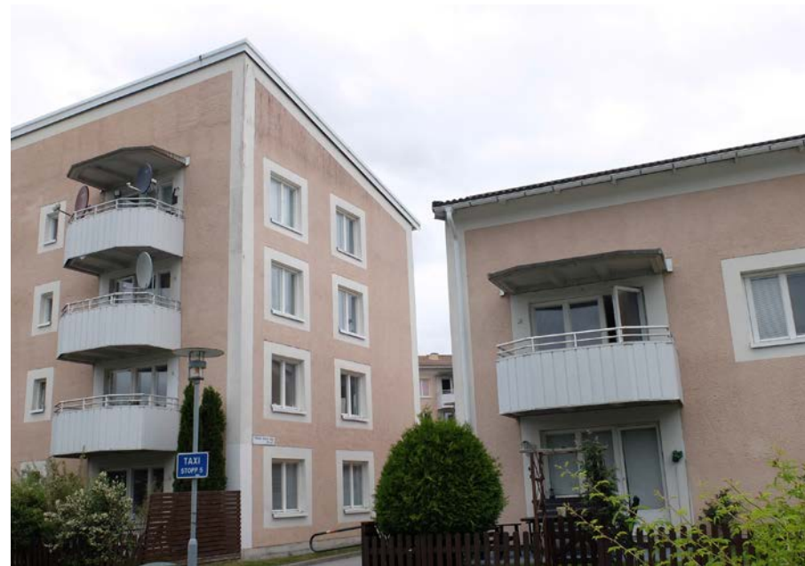
Huset längs i öster i kv. Vitsenapen har trappats ner i våningshöjd till två våningsplan, sannolikt för att bättre anpassas till intilliggande radhusområde.
