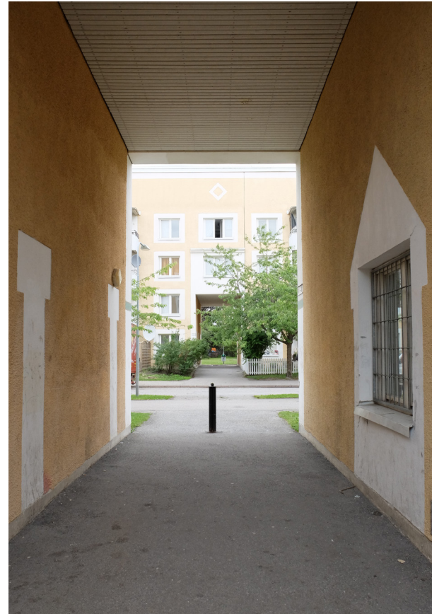
En annan form av dekorativ putsdetalj finns kring de fönster som vetter mot vissa portgångar.
