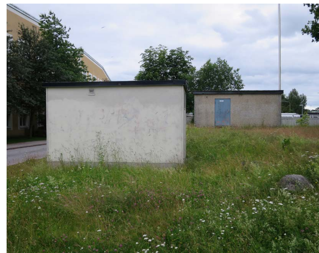
I kv. Åkerväplingen finns en Pumpstation från 1976 (blå dörr) och en nätstation från 1986.
