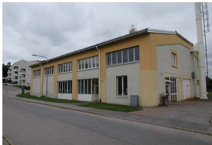
Värmecentralen är belägen i västra delen av området längs med Smedshagsvägen. I bakgrunden skymtar bostadshusen i kv. Akersyran.
