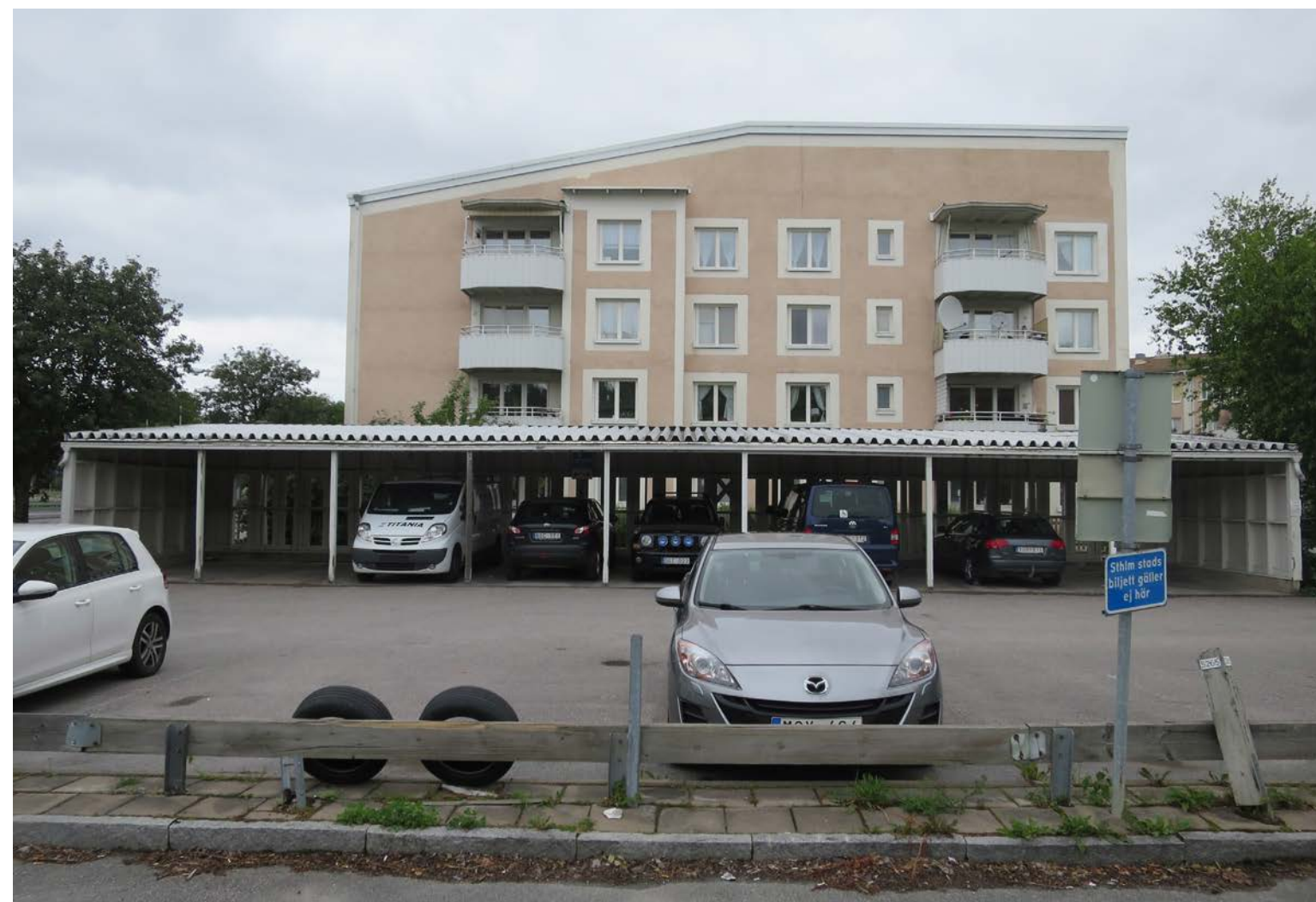
Parkeringsyta utmed Mäster Karls väg med kv. Vitsenapen i bakgrunden.
