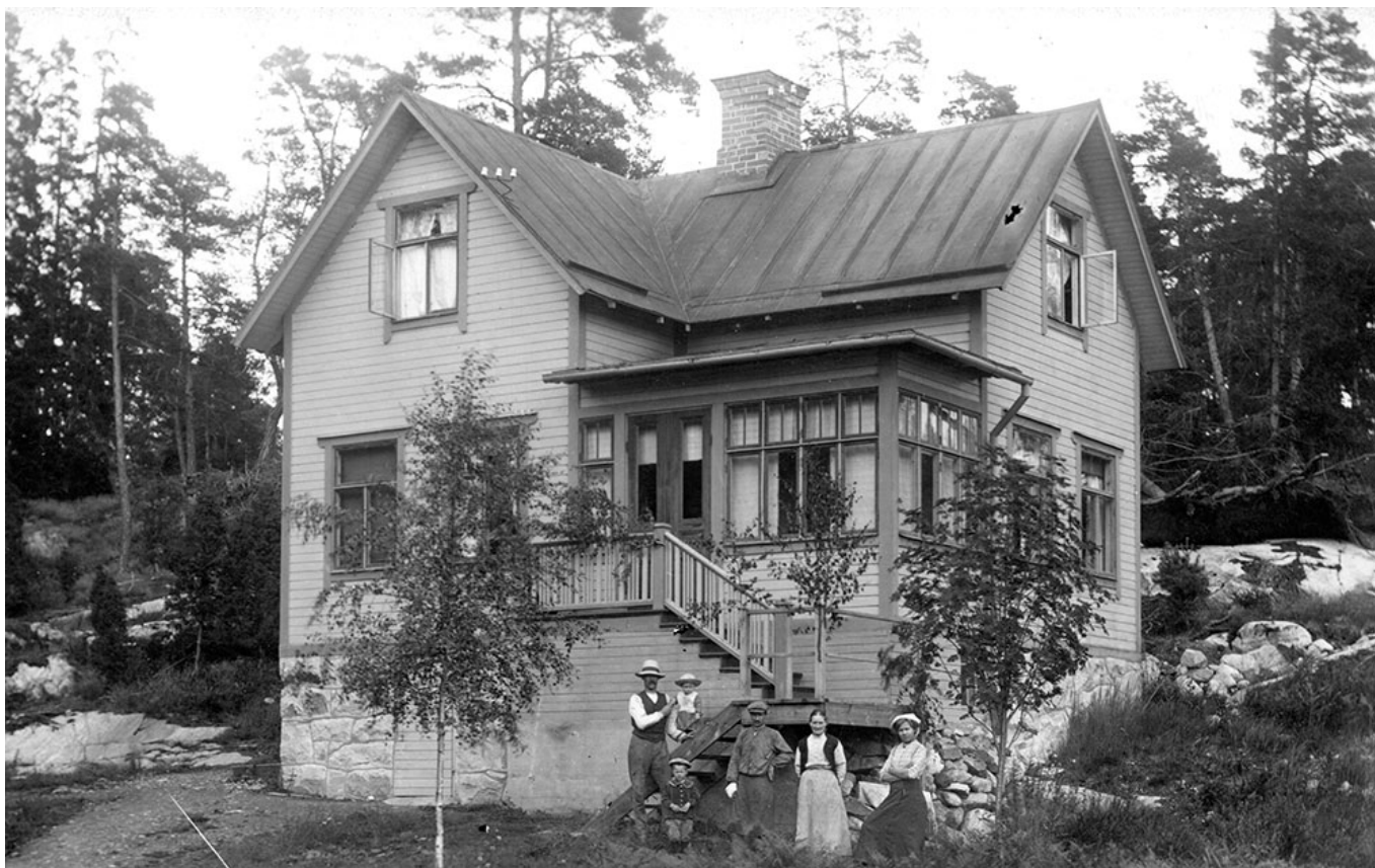
Trädgårdsmästarbostaden Gransäter vid Carl Bondes väg 90 (norr om kv. Vildkornet). Huset uppfördes 1908 för trädgårdsmästaren Nils Larsson och hans familj som står uppställda framför huset. Byggnaden är idag både om- och tillbyggd och svår att känna igen från fotot ovan. Idag används huset som samlingslokal för Hässelby Scoutkår. Källa: Hesselby.com
