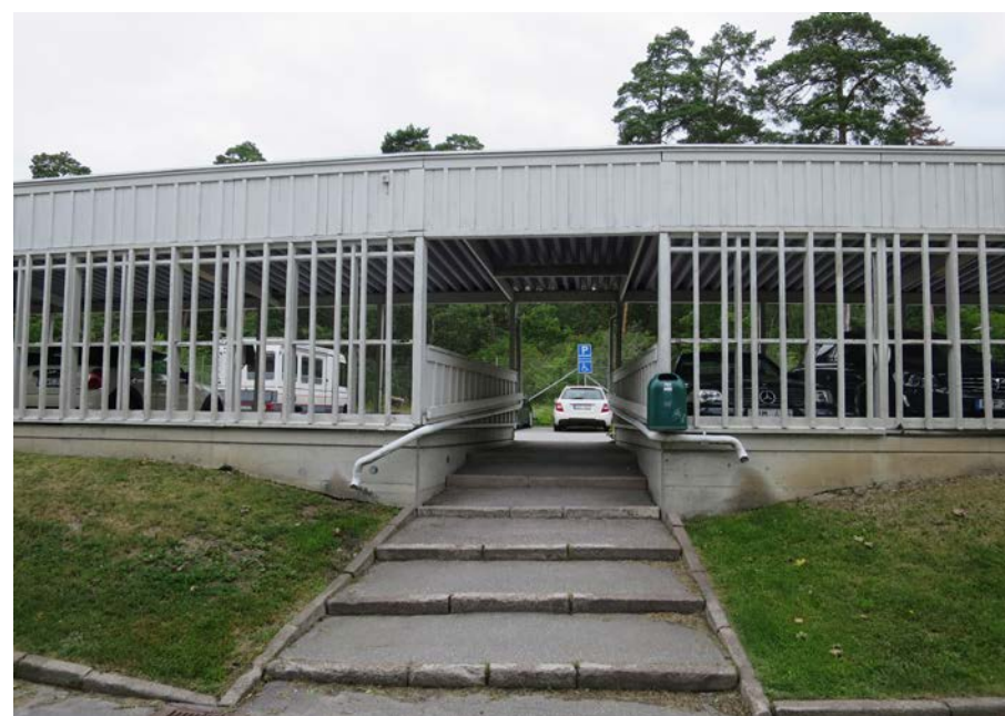
De två carportlängorna i kv. Åkersyrån har spaljerad sydfasad.
