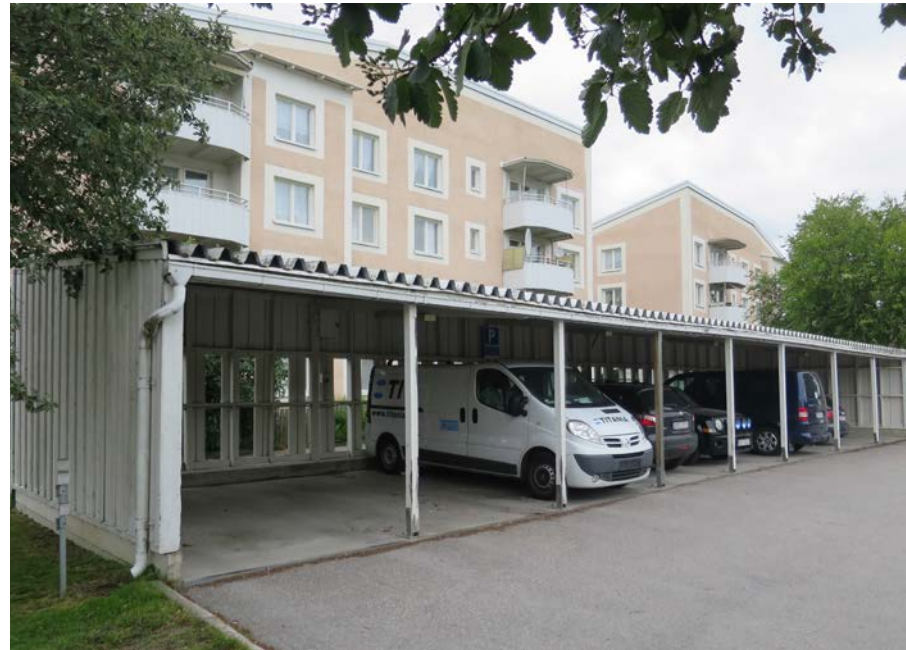
Carports med stående träpanel och pulpettak klätt i sinuskorrugerat plåt.
