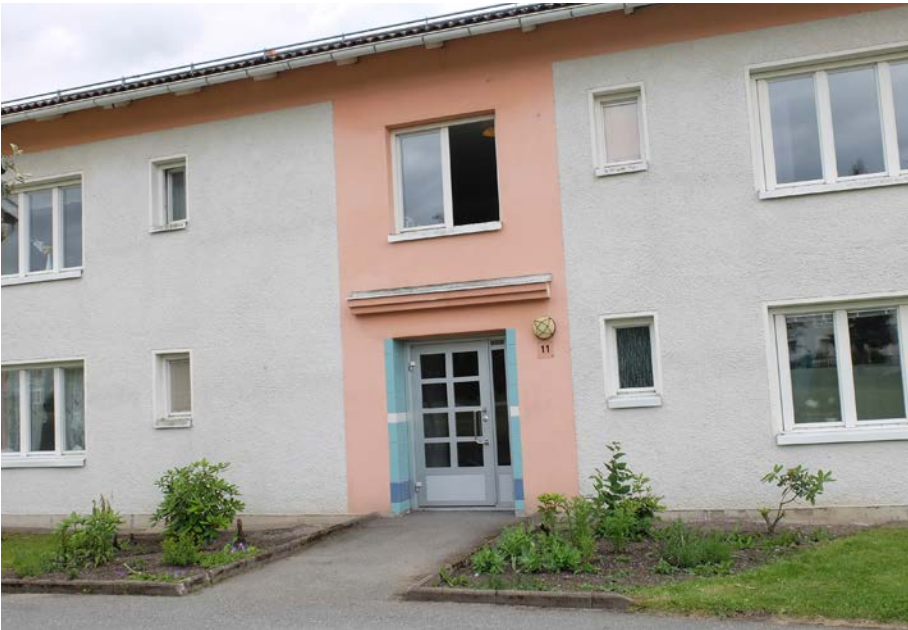
Längornas avsaknad av uteplatser och balkonger mot parkrummet i norr bidrar till en institutionsliknande karaktär.
