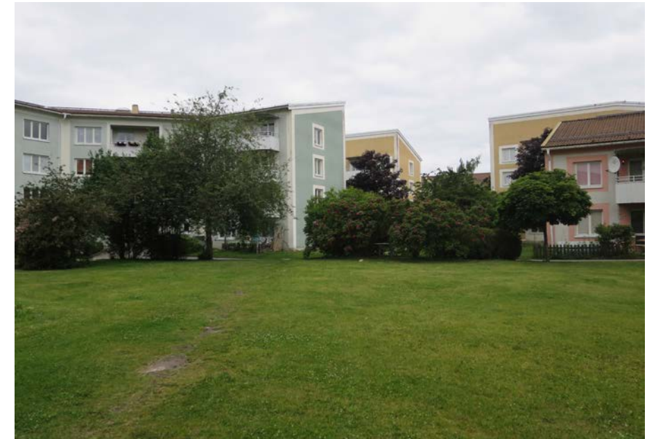
Friliggande punkthus och tvåvåningslänga i kv. Villkornet. I bakgrunden skymtar de högre kvartershusen.
