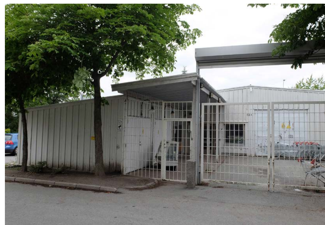
I kv. Åkervädden, intill parkeringsplatserna finns ett f.d. sophus/garage som uppfördes samtida med resten av området. På 2000-talet gjordes byggnaden om till källsorteringsstation.
