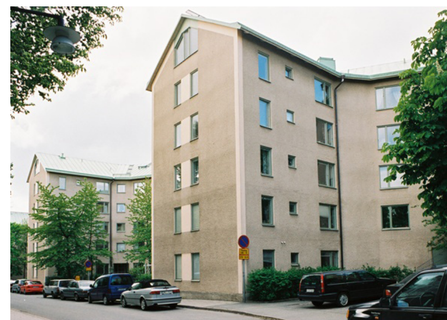
Stjärnhus i Gröndal i kv. Blocket. Källa: RAÄ Bebyggelseregistret.
