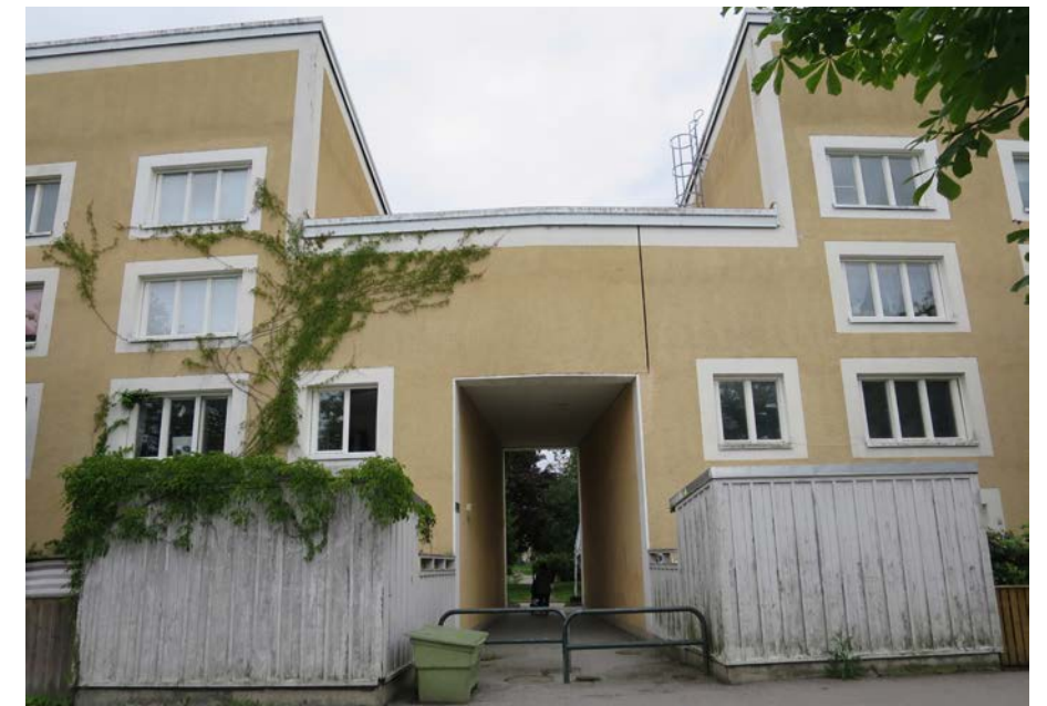
I kvarteren närmst Carl Bondes väg är husen sammanlänkade mot gatan genom en överbyggd portik,
