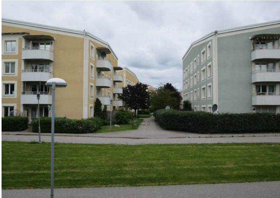
Samtliga hus har spritputsade fasader i dova pastellfärger där varje kvarter har en egen fasadkulör.
