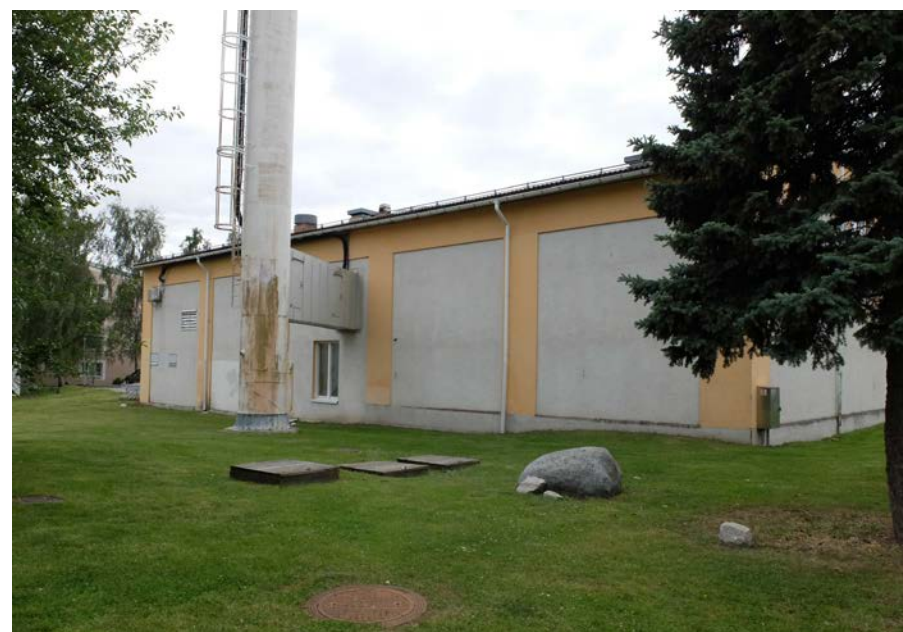
Baksidan av värmecentralen vetter mot parkrummet.
