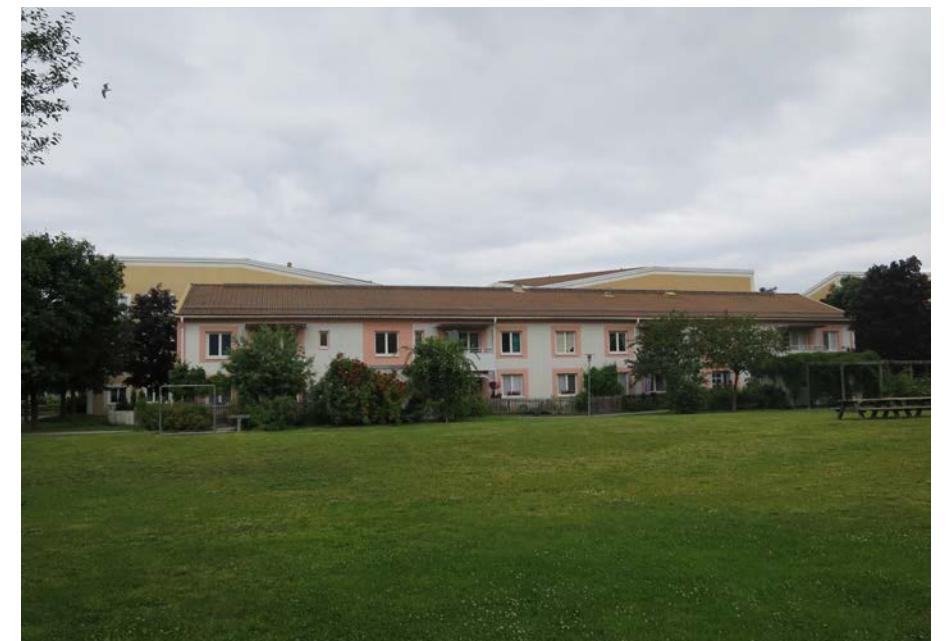
Tvåvåningslänga i kv. Vildkornet vid parkområdet. De högre kvartershusen avtecknar sig likt vingar ovanför längans tak.
