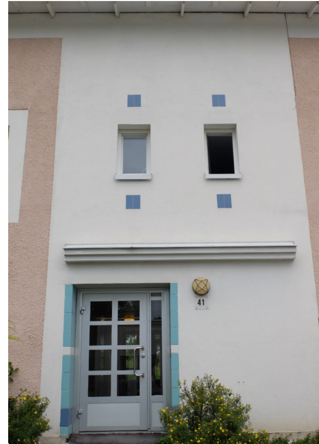
Tvåvåningslängornas entréer har kaklade omfattningar i en starkt kontrasterande nyans. Ovan entrén finns även kakelutsmäckning.
