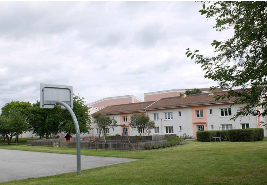
Tvåvåningslängor i kv. Vitsenapen som vetter mot det allmänna parkrummet ("Päronparken") med lekplats och bollplan i förgrunden. De högre bostadshusen avtecknar sig i fonden. Längorna har branta sadeltak och skiljer sig därmed mot kvartershusens vinklade takfall.
