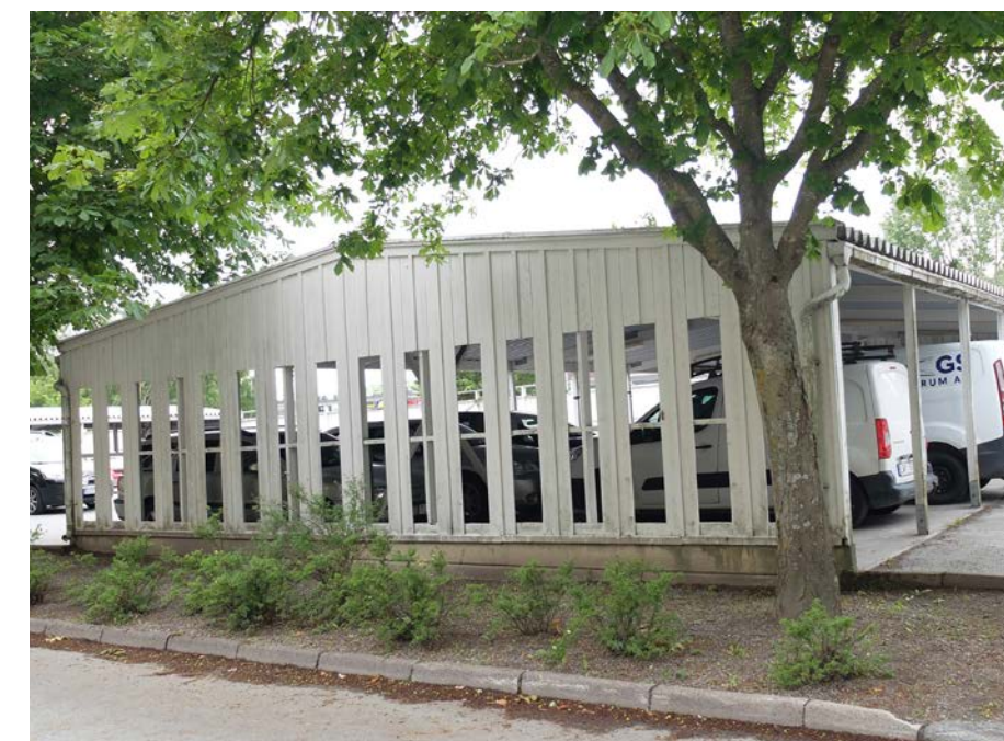
En av parkeringshallarna utmed Carl Bondes väg. Här finns ljusläpp på gaveln.
