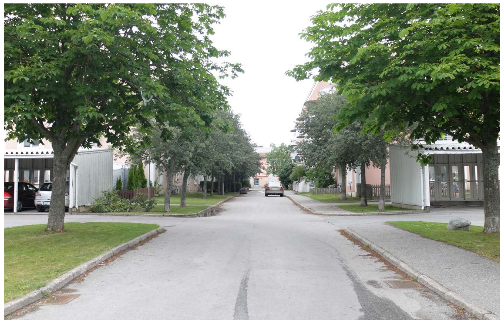
En av de tre angöringsgatorna som utgår från Mäster Karls väg med parkeringsytor på var sida. Angöringsgatorna kantas av uppväxta lövträd med en trottoar på ena sidan av vägen. Trottoarerna är asfalterade med kantsten av betong.
