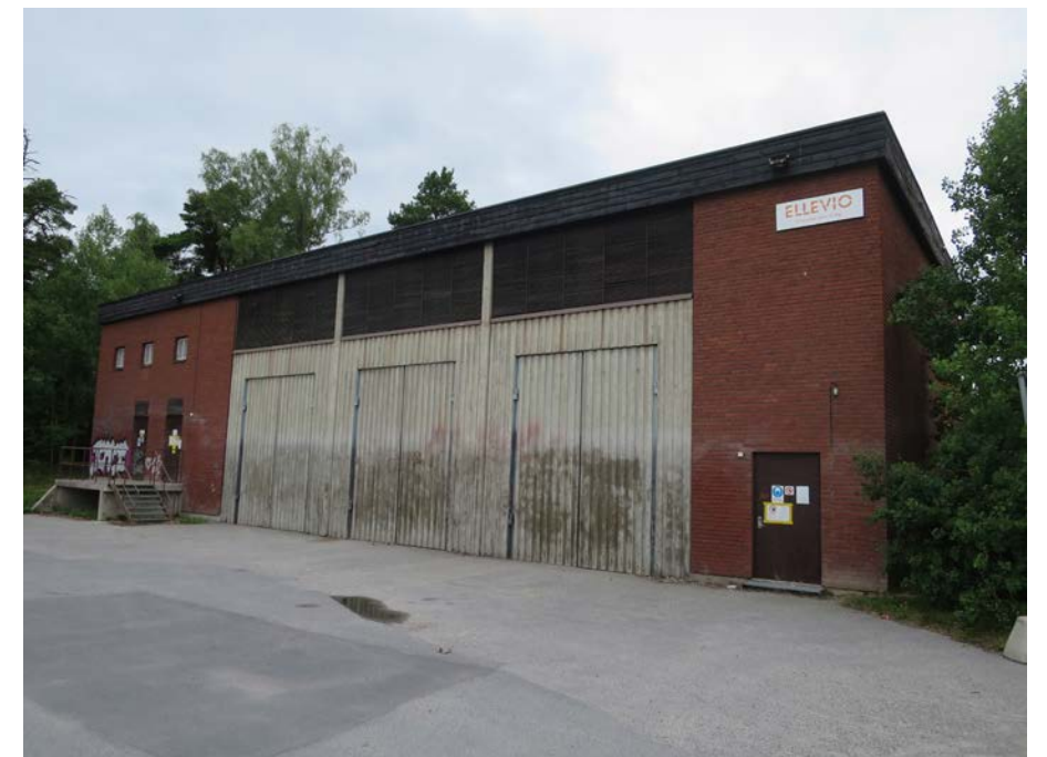
Fördelningsstationen belägen söder om skolområdet i kv. Vårbrodden.
