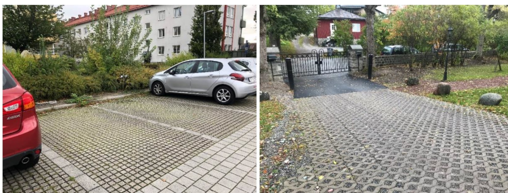
Figur 21. Två exempel på genomsläpplig beläggning genom gräsarmerade betonganläggningar. Översta bilden är från Augustenborg Malmö och nedersta från Villa Pauli Danderyd (Foto: Bjerking).
