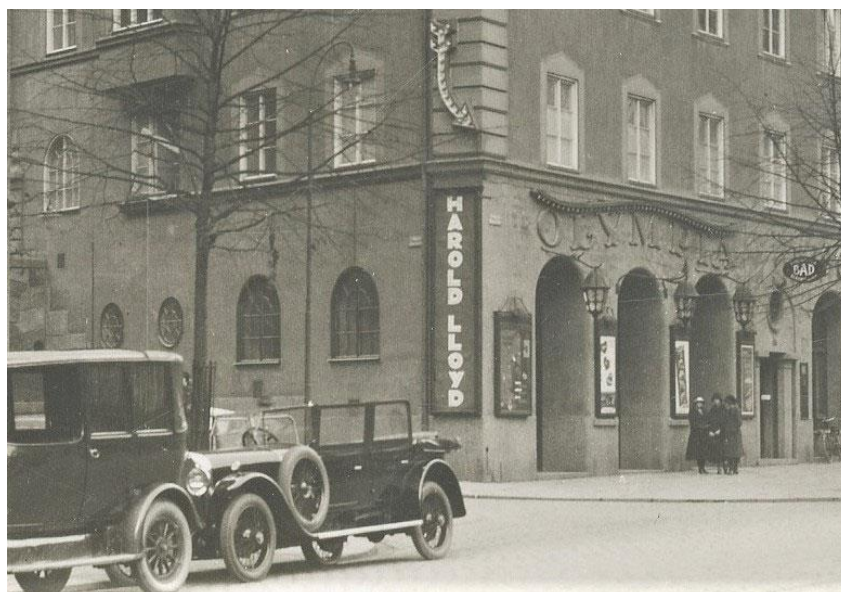
Byggnaden mot hörnet Jutas Backe (till vänster) och Birger Jarlsgatan (till höger) med biografen Olympias entré. Fotografi från 1924.
