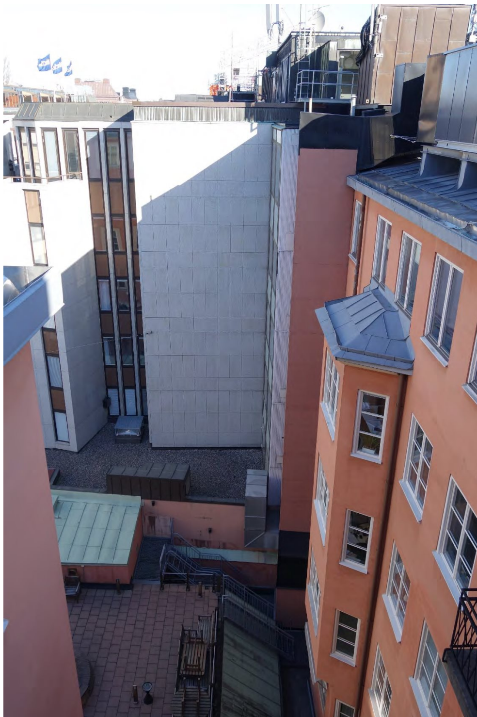
Vy ner mot innergården. Den plattbelagda ytan är ovansidan på biograflokalen. Det kopparbeklädda takfallet längst vänster i bild är ursprungsgaraget tak (idag miljörum).
