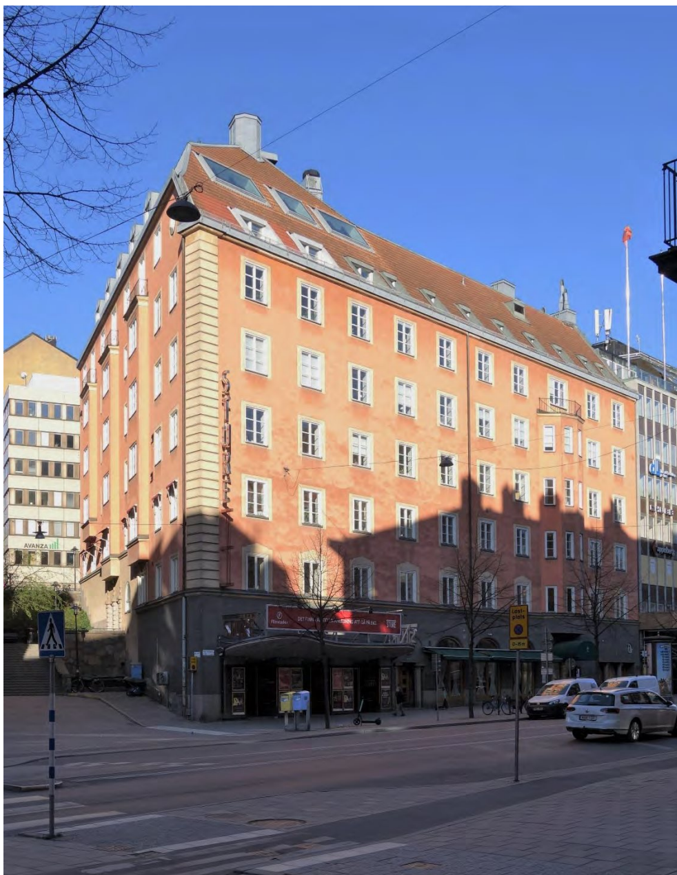
Fasaderna mot Birger Jarlsgatan och Jutas Backe i april 2020.
