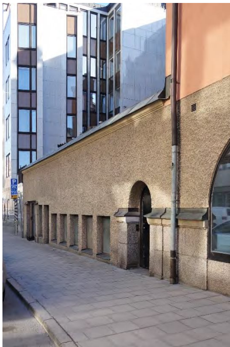
Till vänster: Muren utmed Regeringsgatan, bakom vilken biografalongen ligger. Porten närmast i bild leder upp till innergården, ovanpå biograflokalen. Den låga, tidigare betydligt högre dörren längst bort i muren ledde tidigare in till ett garage (jämför med äldre fotografi tidigare i handlingen). Till höger: Vy genom gallret till dörren framför trappan som leder upp till innergården.
