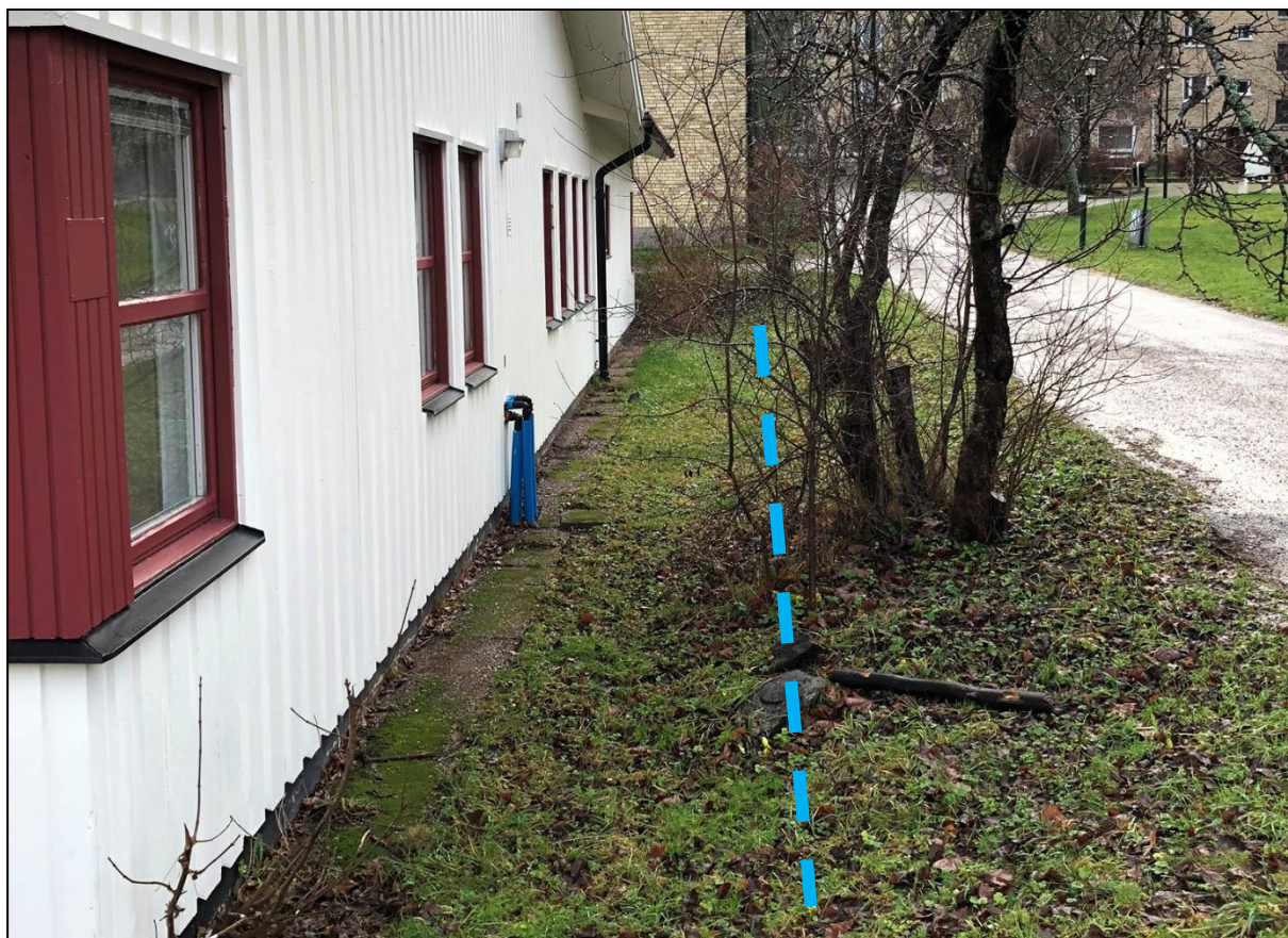
Figur 5-8. Västra sidan av skolbyggnaden, fotograferad norrifrån. Ett förslag på placering av ett svackdike eller ränna är markerat med blåstreckad linje.
