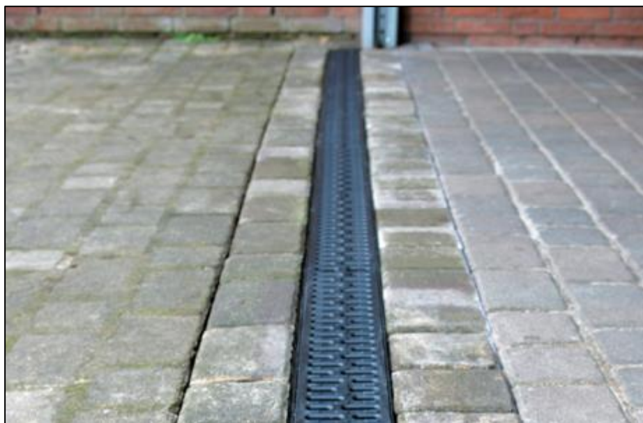
Figur 5-5. Exempel på hur en gallerförsedd ränna kan integreras i plattsättning. Bild från ACO Nordic AB, 2020.
