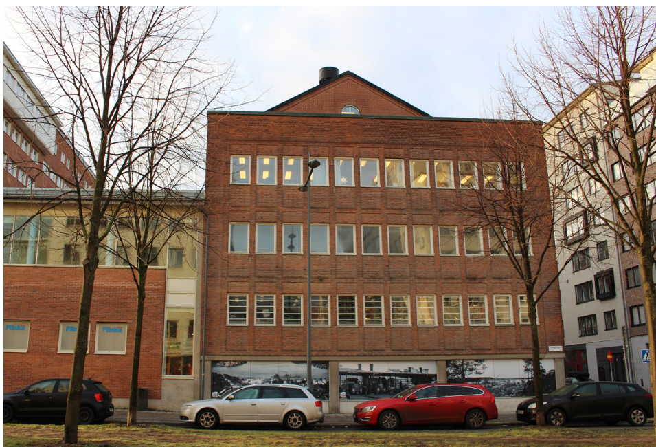
Tillbyggnaden på B 42 från 1964-65.
