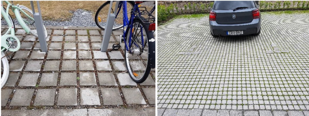
Figur 26. Genomsläpplig yta på cykel- och bilparkering.
