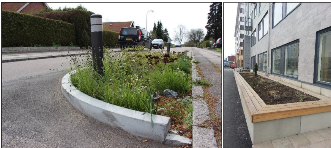
Figur 19. a). Nedsänkt regnbädd i gata. b). Alternativ på regnbädd där det finns mindre möjlighet att sänka ned bädden (Norconsult, 2014).
