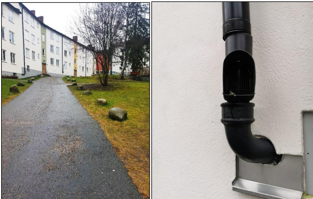
Figur 11. T.v. Takdagvattnet leds via stuprör in i byggnaderna T.h. Stuprör med rensträtt. Foto: Norconsult AB
