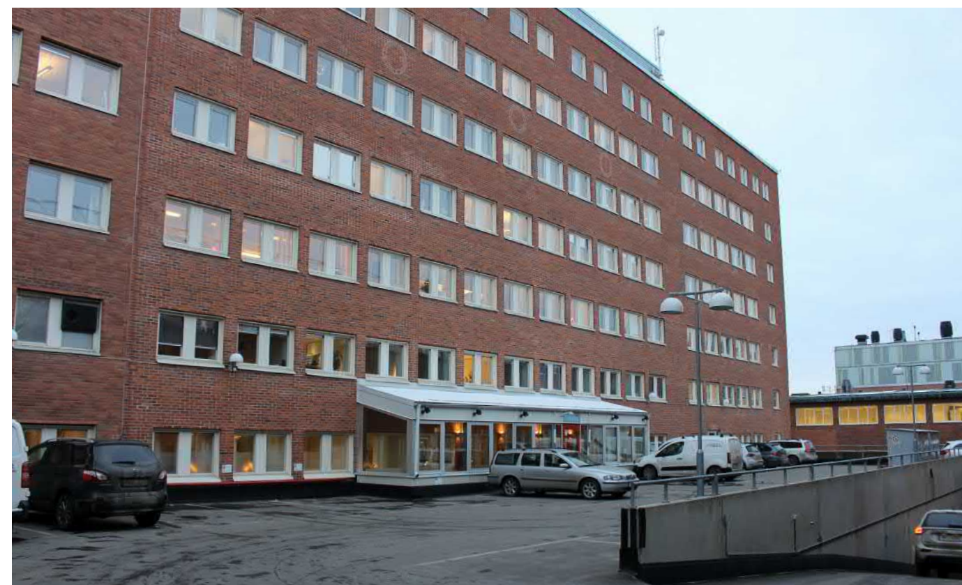
1980-talsbyggnadens (B20) fasad mot gården och parkeringsdäcket. Däcket, lanterninen och butiksentrén tillkom 2009. Fasaden har i övrigt bevarat ursprungligt utseende.
