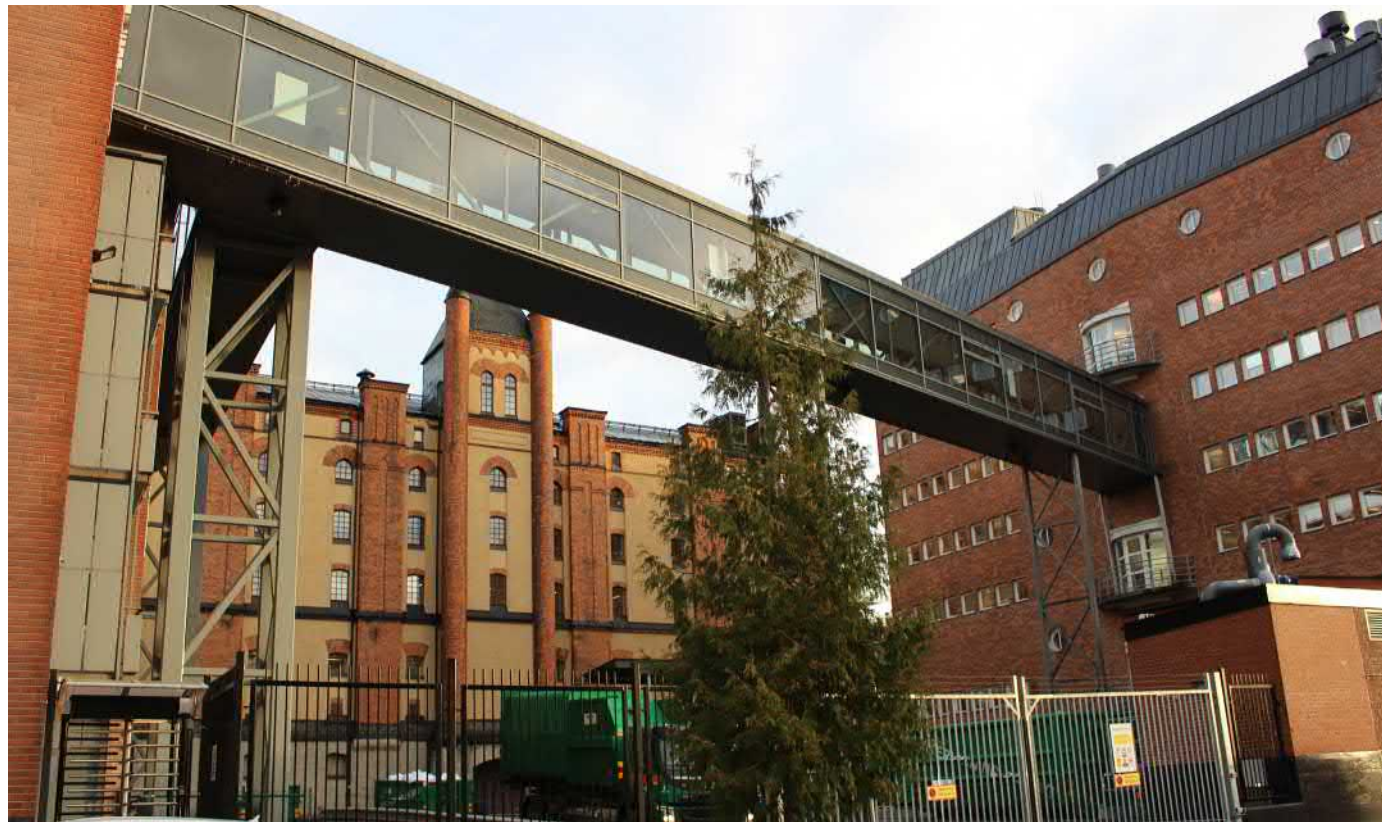
Glasade förbindelsegångar som sammanlänkar de olika byggnadskropparna präglar Octapharmas område. I bakgrunden skymtar f.d. Stora bryggeriet.
