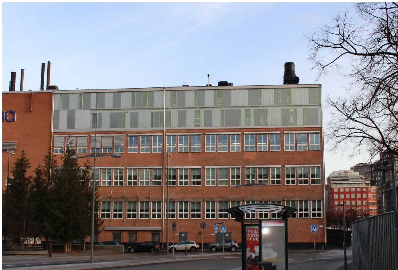
Octapharmas byggnad i hörnet Elersvägen-Nordenflychtsvägen har byggts på med nya våningar 2003-05.
