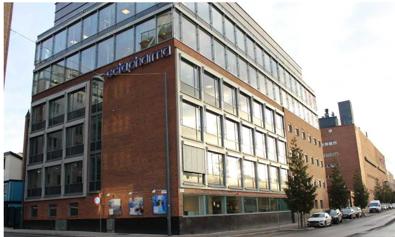
Tegelbyggnaderna som vetter mot Elersvägen utgör en del av Kabis utbyggnad från 1960- och 70-talen och har även byggts på med ytterligare våningsplan under 2000-talet.
