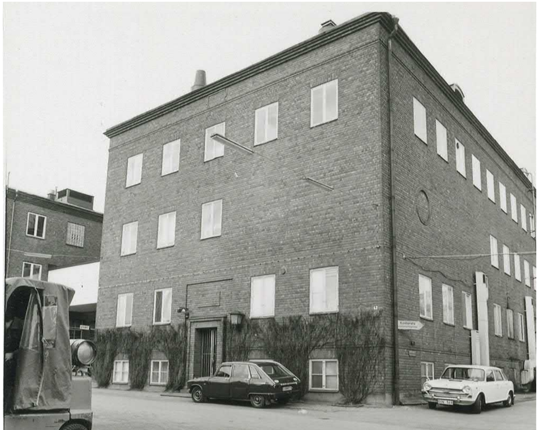
Penicillinfabrikens gavel, 1971. Det fönsterlösa partiet markerar ett kylrum för penicillinhantering. SSM.
