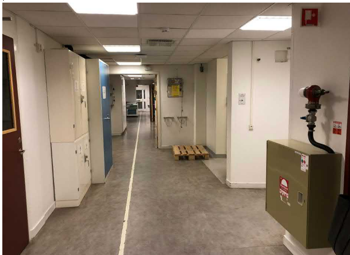
Korridorparti med plastmatta och nedpendlat akustiktak med infällda takarmaturer.
