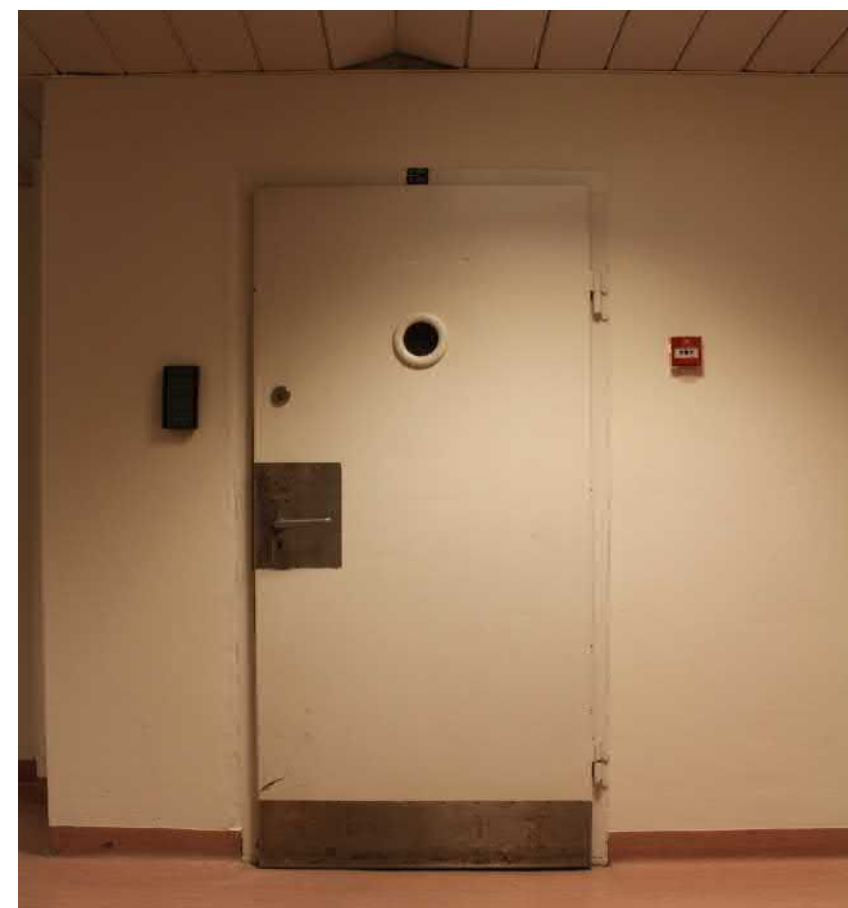
Ursprungliga ståldörrar med runda öppningar finns bevarade i källarplanet.
