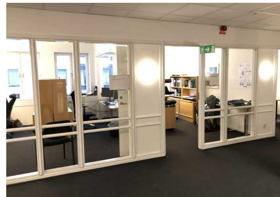
Sentida skiljeväggar med stora glaspartier. Taket utgörs av ett nedpendlat akustiktak, golvet är klätt med en mörk matta.
