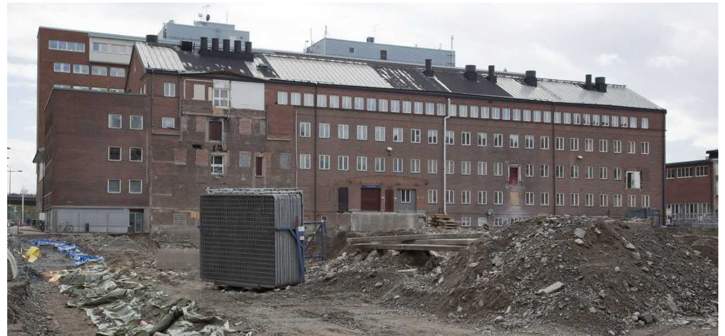
B42 (penicillinfabriken) sedd från Lindhagensgatan under pågående rivning i kvarteret Leendet 2011. 1960-talstillbyggnades fasad (till vänster i bild) överlappar 1940-talets. SSM.
