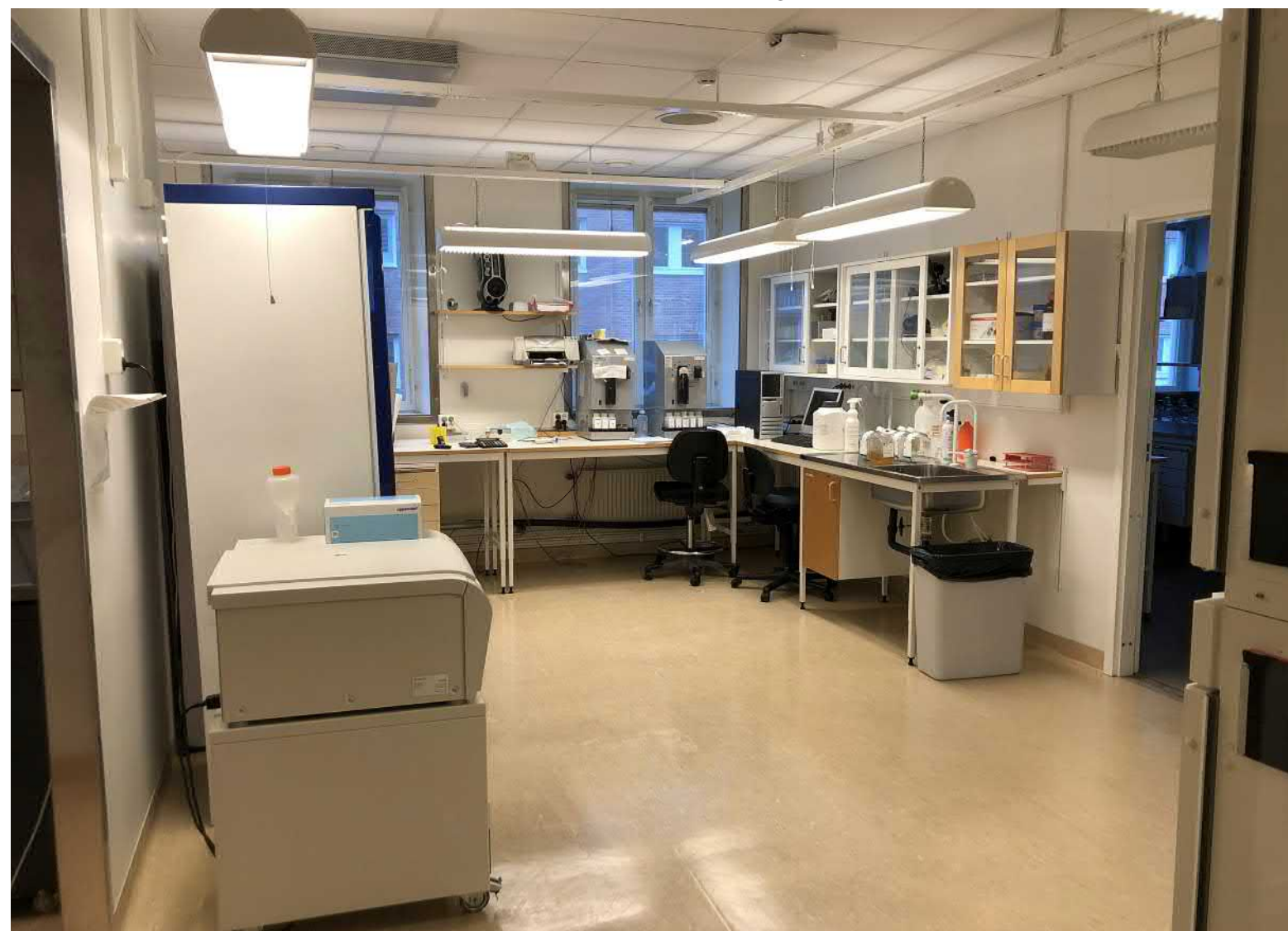
Laboratoriemiljö med plastmatta, akustiktak och nedpendlade lysrörsarmaturer. Notera den metallklädda dörrnischen till vänster i bild, samt fönstrens inre glas monterade i ramverk av rostfritt stål i nischens innerkant.
