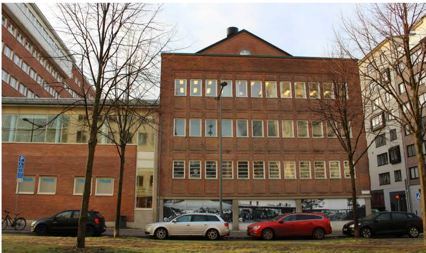
1960-talstillbyggnaden mot Lindhagensgratan har en rationellt utformad fasad med ett bearbetat rutnät-mönster i tegel. Det ursprungligen öppna, pelaromgärdade gatuplanet är idag igensatt.
