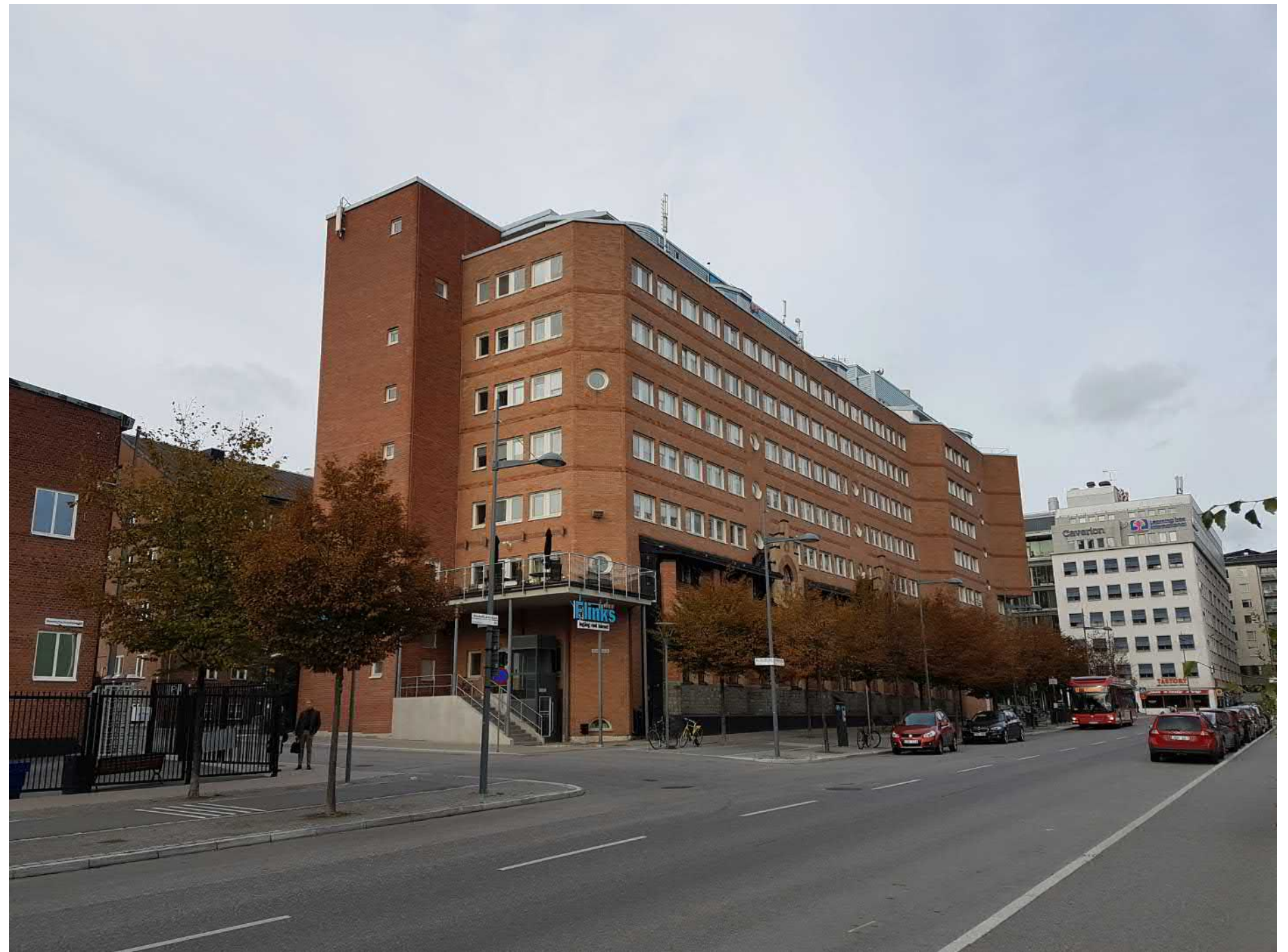
Hornsberg 10 från Nordenflychtsgatan mot nordost. Under 1980-talet, då den befintliga kontorsbyggnaden (B20) tillkom, fanns en gästparkering mellan gata och fasad. 2012-14 genomfördes en större ledningsomläggning och breddning av gatan. I samband med vägbreddningen anlades en gång- och cykelväg med trädrader på var sida. Mot Hornsberg 10 finns en busshållplats och parkeringsfickor.
