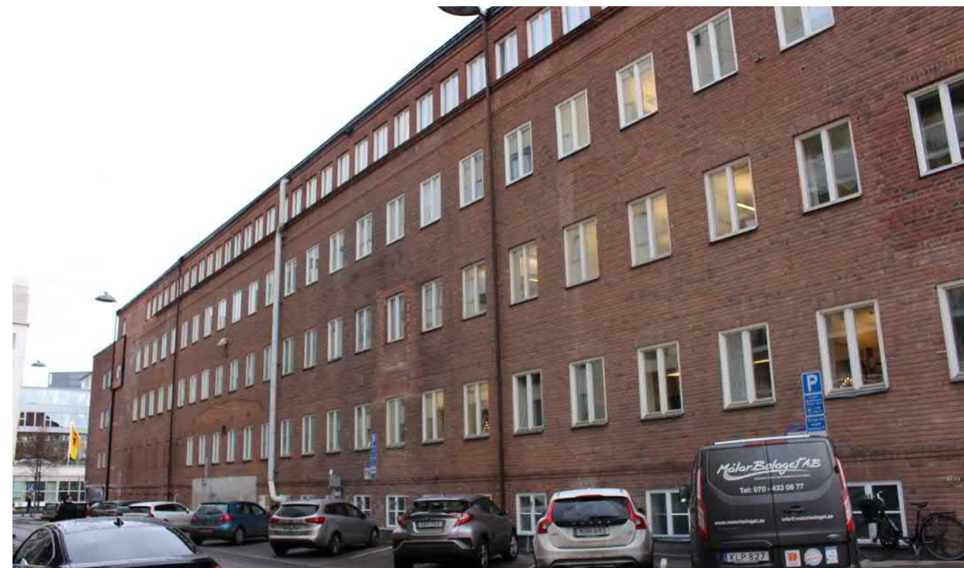
Fasad mot Lennegrensgratan med parkeringsplatser längs byggnadskroppen. Fasadens fönster är sen-tida, men i huvudsak placerade i ursprungliga lägen. Murverkslagningar efter rivna byggnadsdelar och lastkaj samt igensättning av fönster har påverkat byggnadens karaktär.
