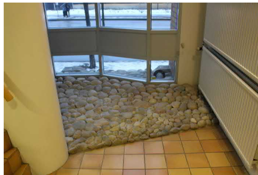
Kullersten som ursprungligen utgjorde en del av den yttre markbeläggningen byggdes in i samband med att entrén flyttades ut.
