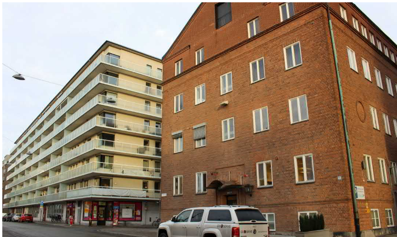
Bostadsbebyggelse inom fastigheten Leendet uppfördes 2010-11 och är beläget direkt nordväst planområdet och den f.d. Penicillinfabriken.
