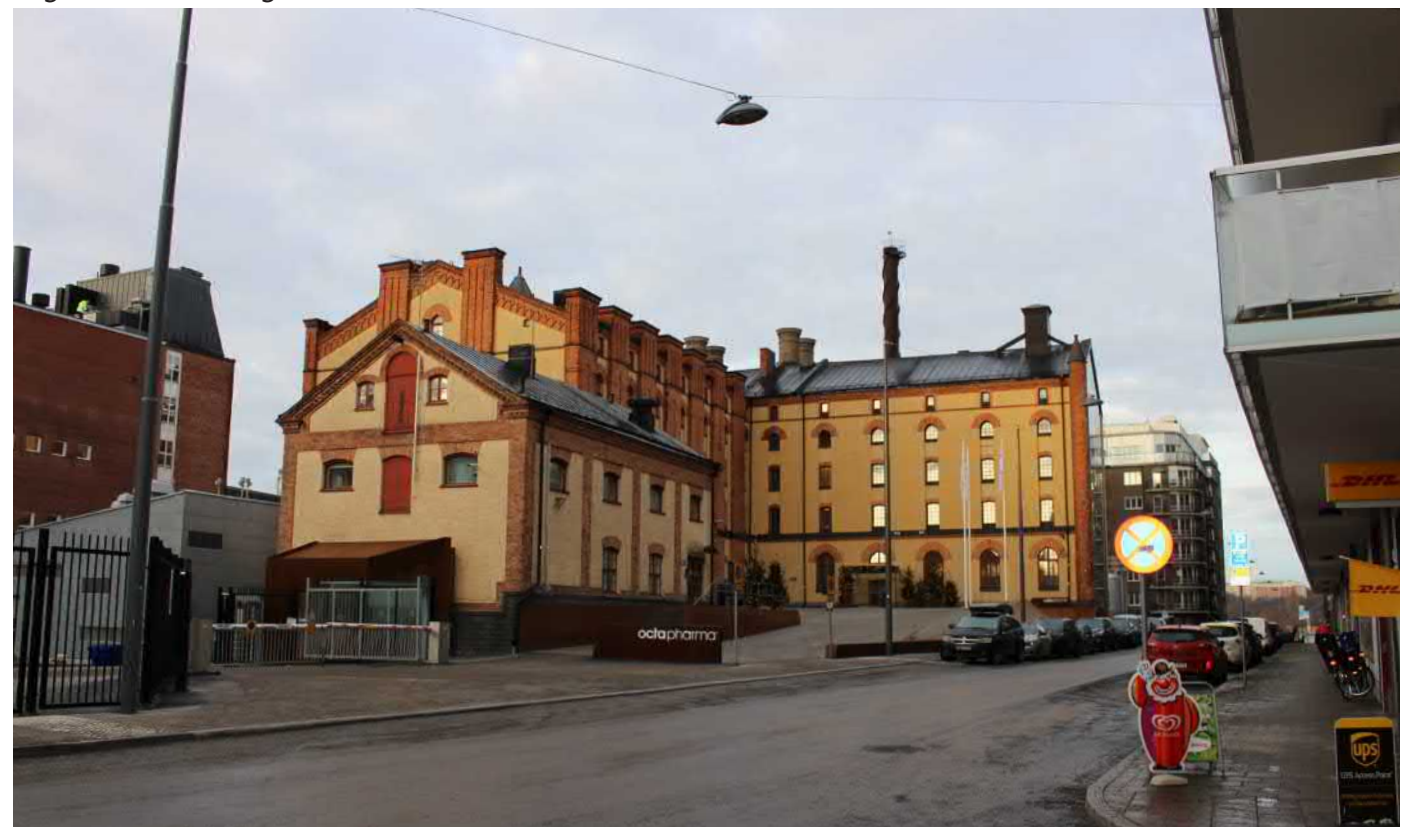
Den omvandlade och ombyggda byggerianläggningen från 1890-talet. Den tidigare bryggerigården är nu till stora delar hårdgjord och staketomgärdad för Octapharmas verksamhet. Den nya gården och terrasseringen vid entrén med mur mot gatan tillkom 2015.
