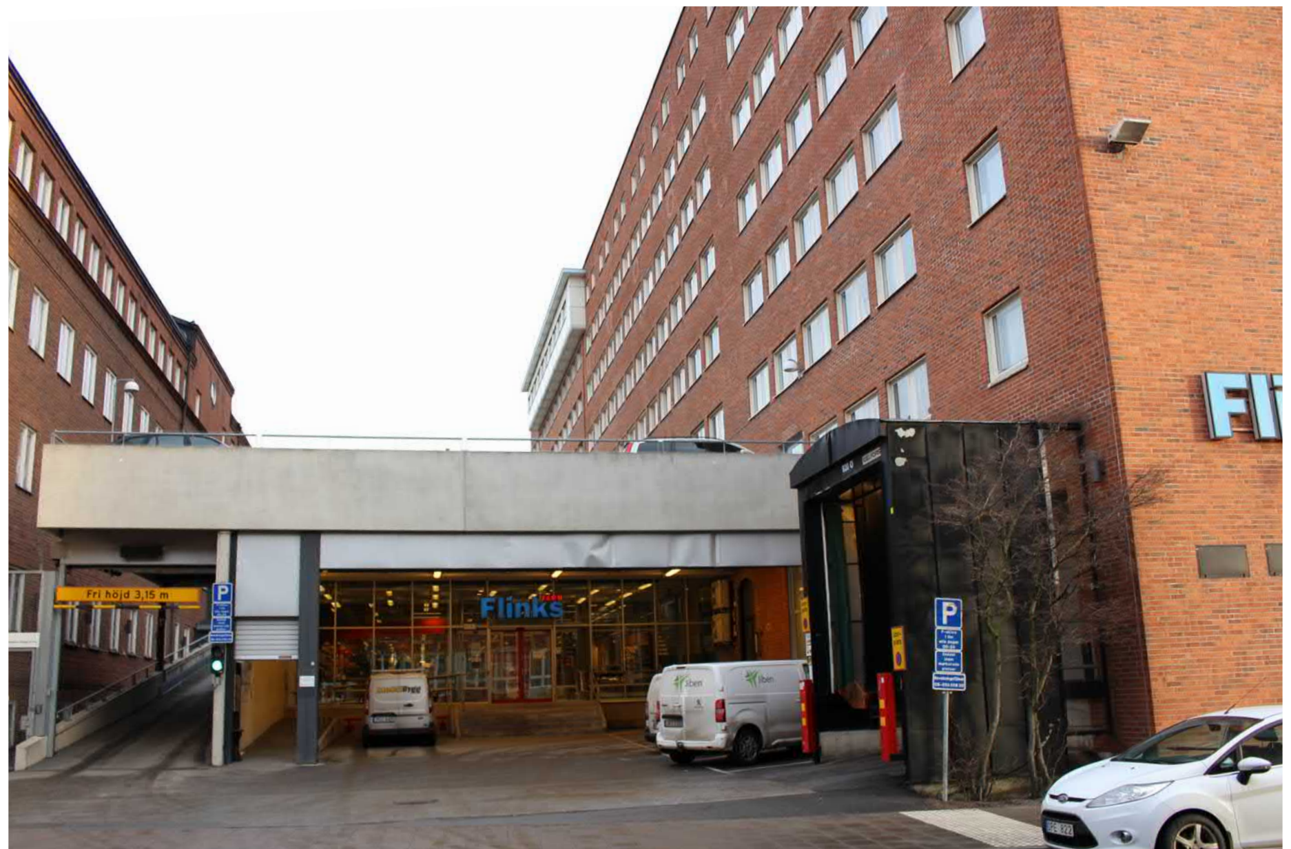
Tillbyggnaden av B28 från 2009, med butiksentré och körramp mot Lars Forssells gata.
