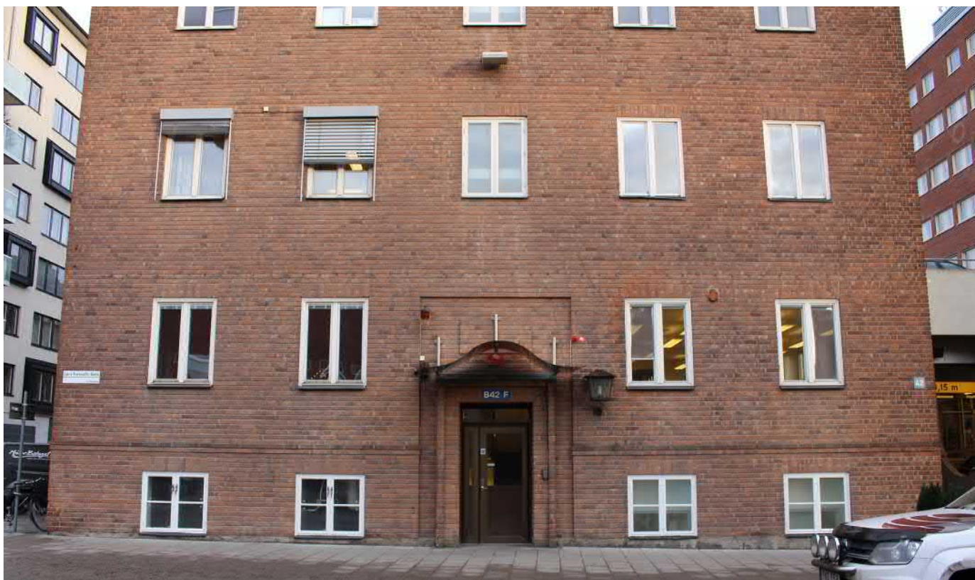
Ursprunglig entré på den sydvästra gaveln markerat genom ett indraget fasadfält och utkragande tegelomfattningar. Entréport och skärmtak är inte ursprungliga. Fönstren i sockelväningen är sannolikt ursprungliga. Övriga fönster har grövre fönstersnickerier, och tillkom sannolikt under 1980-talet.
