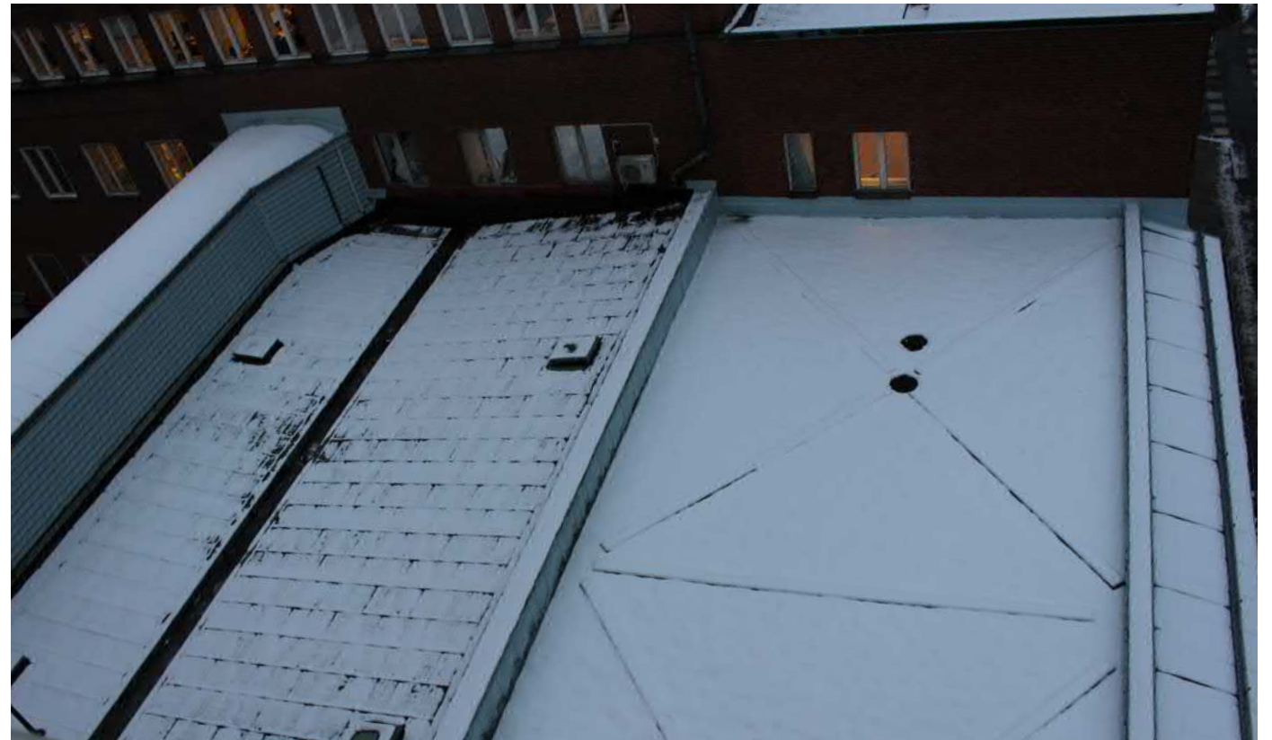
Till vänster i bild syns den förbindelsegång som binder samman B42 (penicillinfabriken) och B20 (1980-talets kontorsbyggnad). Den äldre 1960-talsdelen har bevarat ett tidstypiskt koppartak, vars skivtäckning avtecknar sig tydligt under snön. Till höger syns taket till 1980-talstillbyggnaden.)
