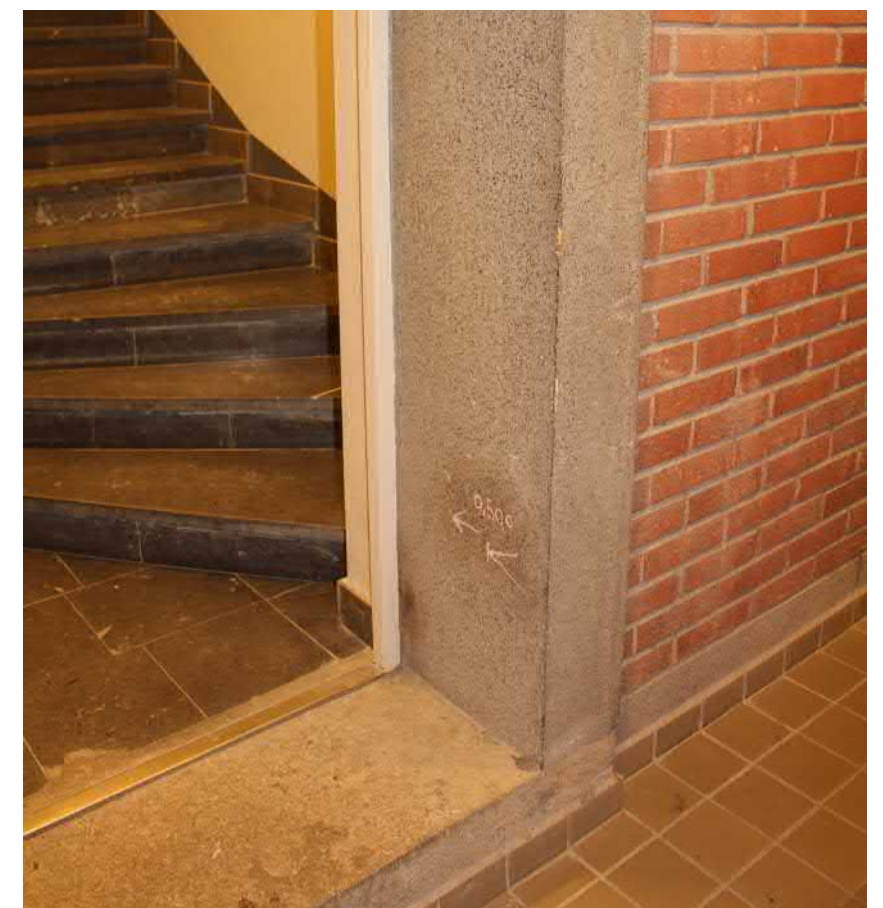
Anslutning mellan trapphus i 1940-talsbyggnaden och den tillbyggda 1960-talsvolymen.
