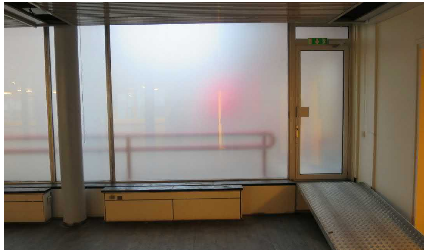
Det nedpendlade innertaket skymmer de äldre fönsterpartiernas övre del, och rutorna har försetts med insynsskydd (se bild på ursprungligt utförande på s. 33). En utrymningsdörr leder ut till den överbyggda gården.
