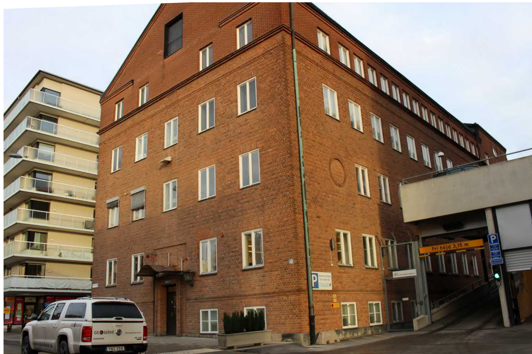
Gavelfasaden mot Lars Forssells gata. Det övre våningsplanet tillkom 1987. Takformen förändrades vid samma tillfälle, från det ursprungligen valmade sadeltaket till sadeltak med gavelfasad som fortsätter till taknock. Den ursprungliga byggnadsvolymens höjd kan avläsas genom den profilerade takfotslisten.
