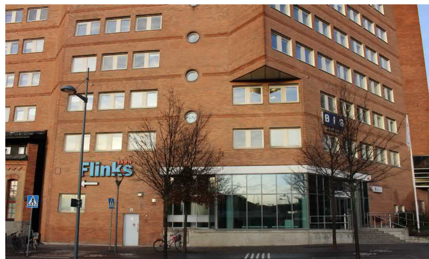
Entrépartiet vid det nordöstra hörnet flyttades ut i liv med den övriga fasaden på 2000-talet. Entréplatsen försågs i samband med detta med ny betongmur och trappa. Fasaden har i övrigt bevarat ursprungligt utförande.
