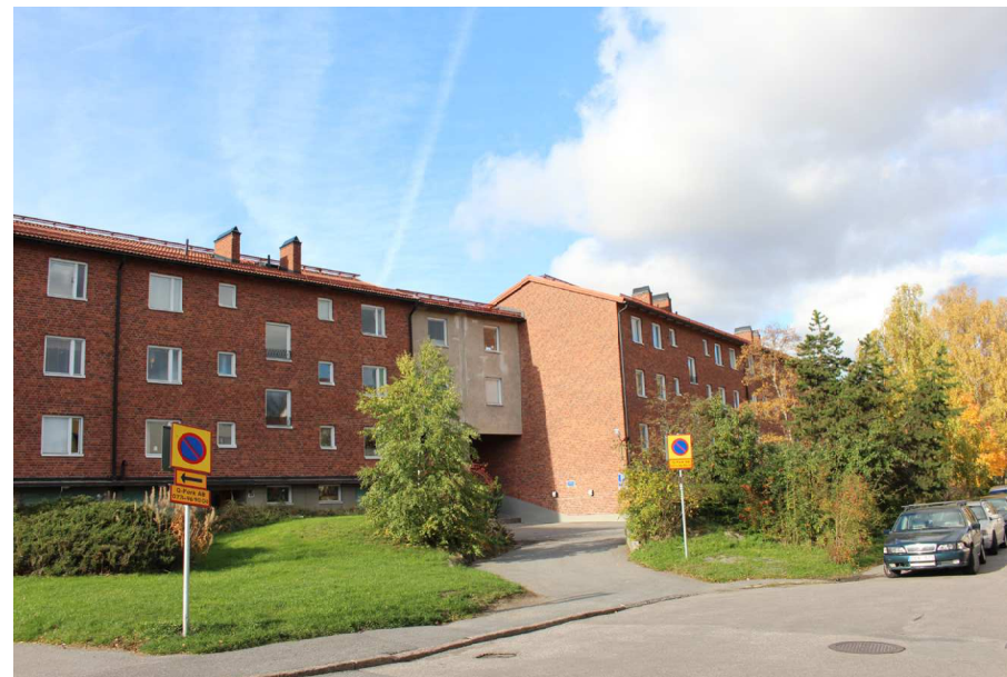
Lamellhus i rött tegel med putsinslag.
