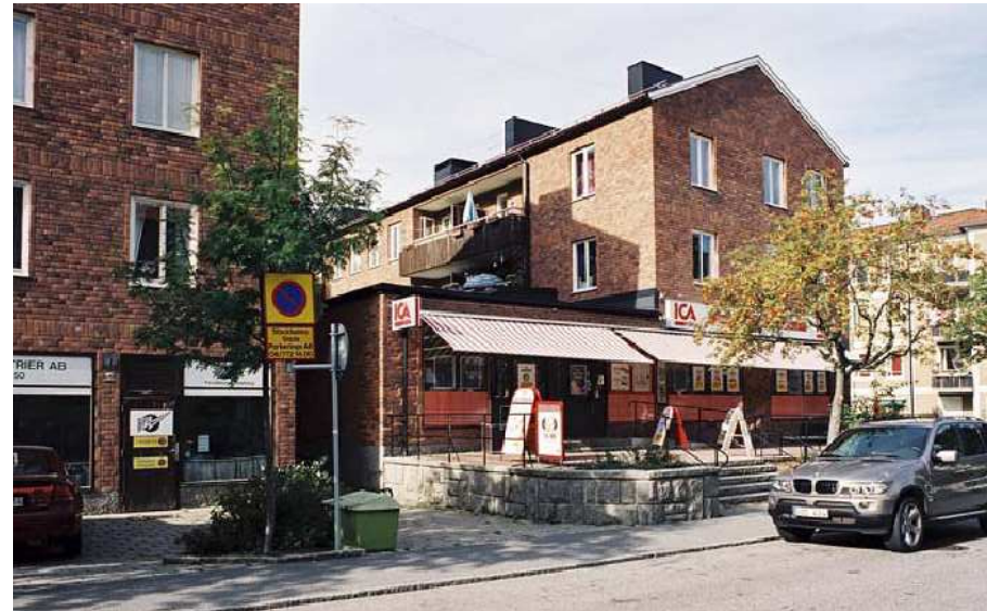
Kv Långpipan i Hökarängen. Lamellhus med integrerad butikslokal i bottenvåning som skjuter ut mot gårdssidan. Foto från 2005, Bebyggelseregistret.
