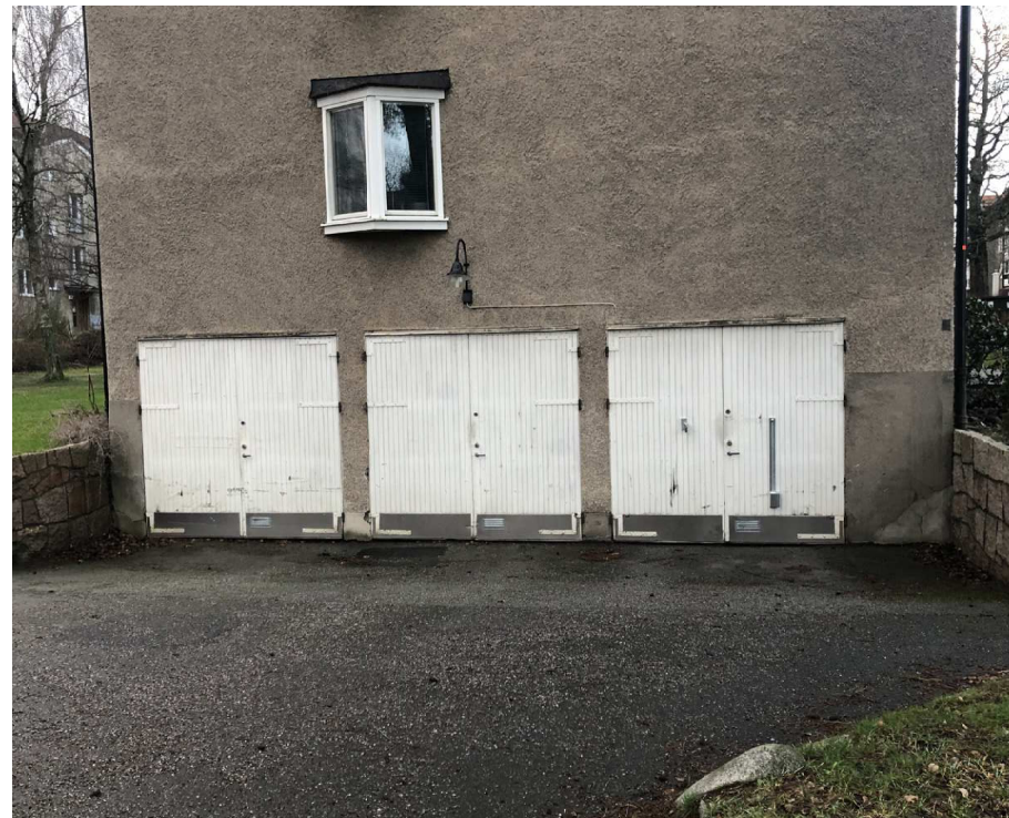
Garage integrerat i lamellhusets källarvåning med infart på gaveln. Foto: Tyréns 2020.
