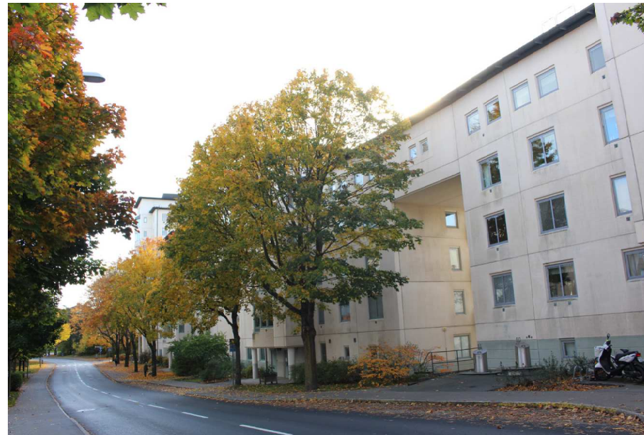
HSB:s förtätningsprojekt med äldrebooster och flerbostadshus från 1990-talet längs med Trollesundsvägen, öster om centrum. Området söder om grupphuset har bebyggts med radhus.
