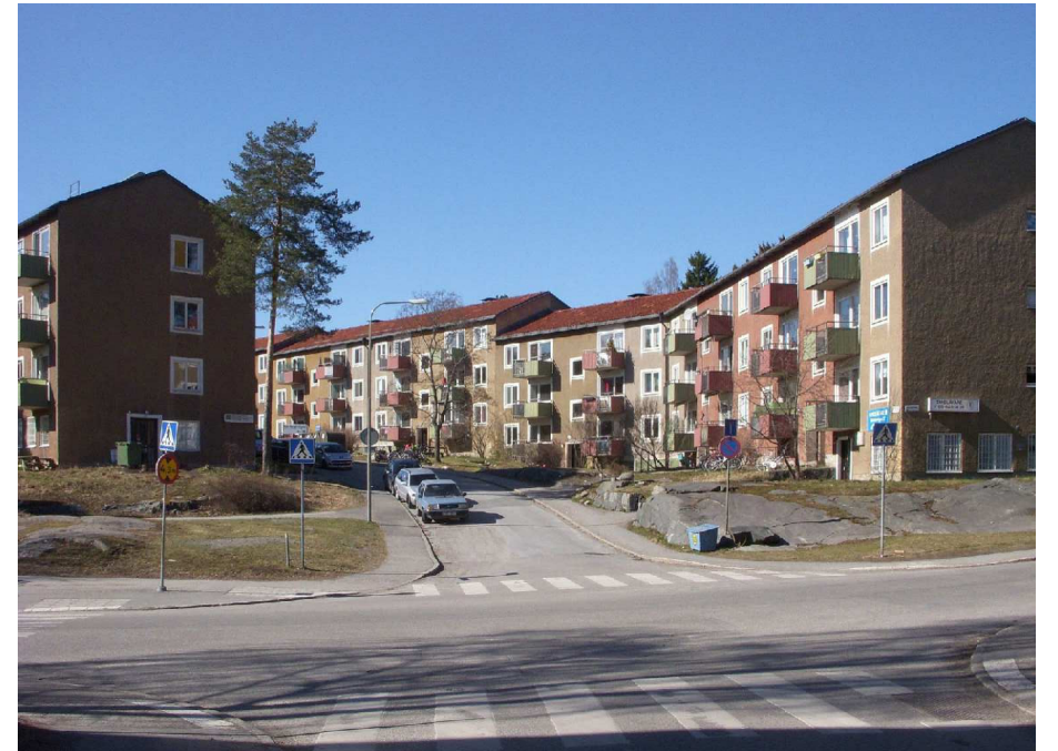
Vikstensvägen i Kärrtorp. Natur- och terränganpassade lamellhus med färgsättning typisk för folkhemsperioden. Foto: Holger Ellgard, 2012, Wikipedia.
