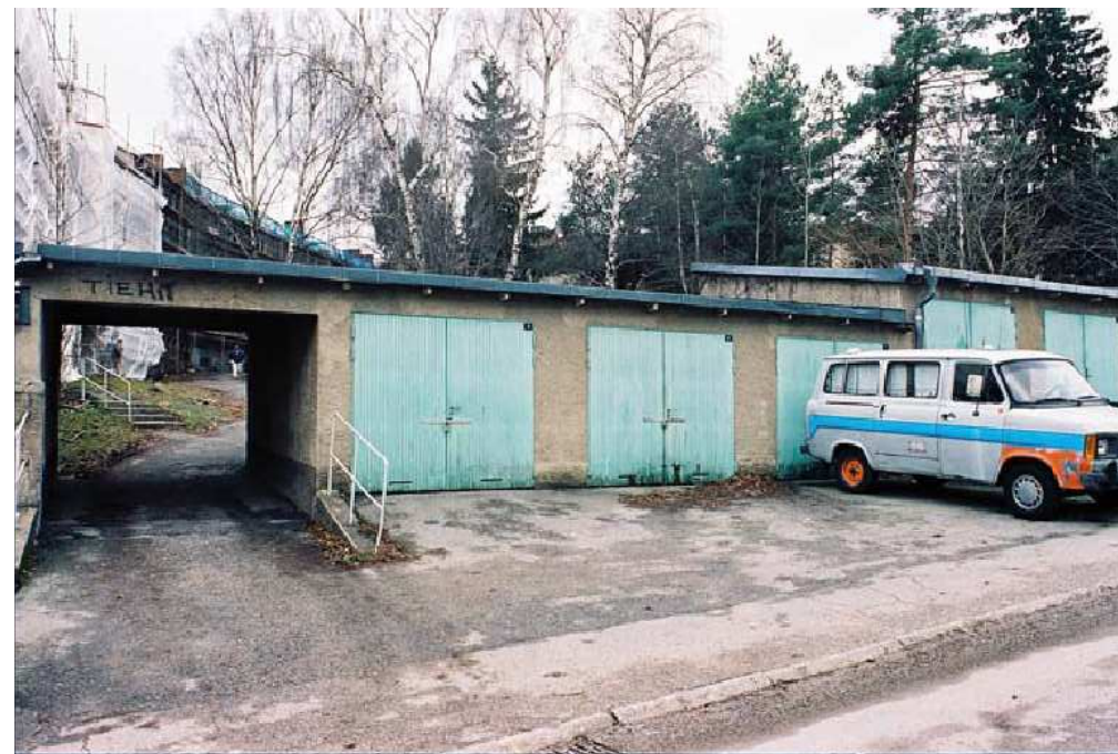
Garagelängan, innan fasadrenovering. Foto: Stadsmuseet, 2005. Bild hämtad från Bebyggelseregistret.
