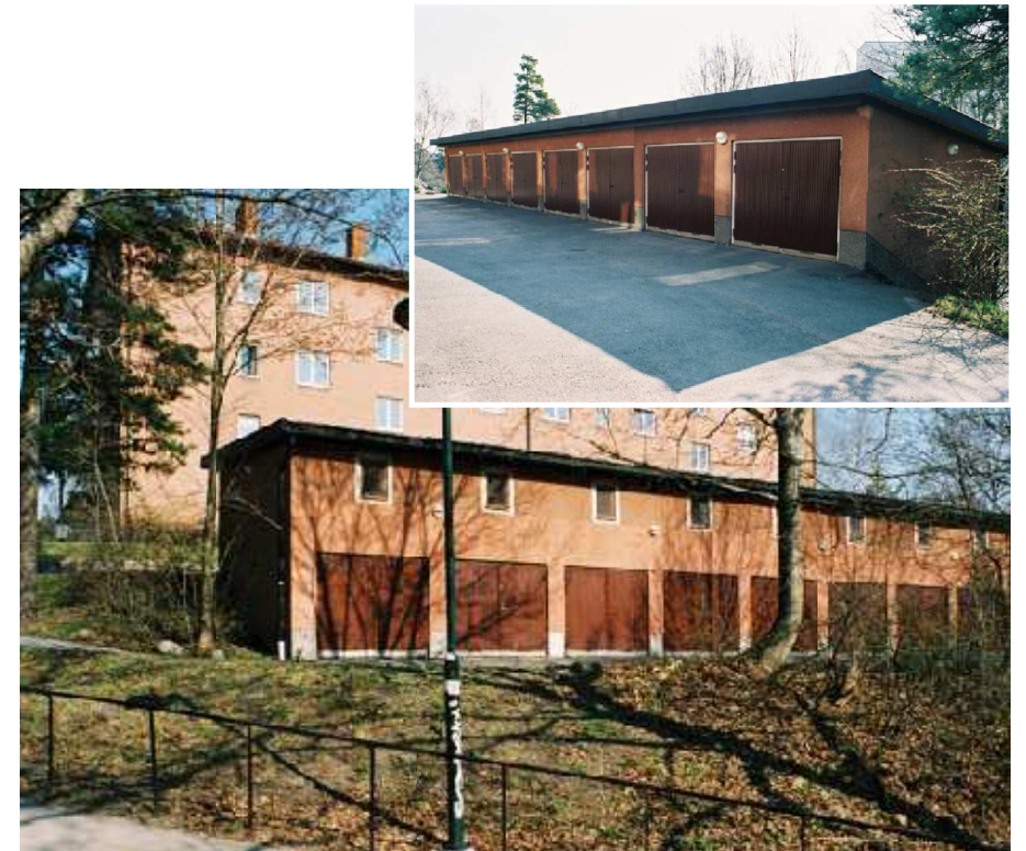
Friliggande garagelänga i souterräng på Skanörvägen i Björkhagen. Garaget från mitten av 1950-talet har bevarad ursprunglig karaktär. Garage är även införlivat i bostadshusets bottenvåning. Foto: Stadsmuseet via Bebyggelseregistret.
