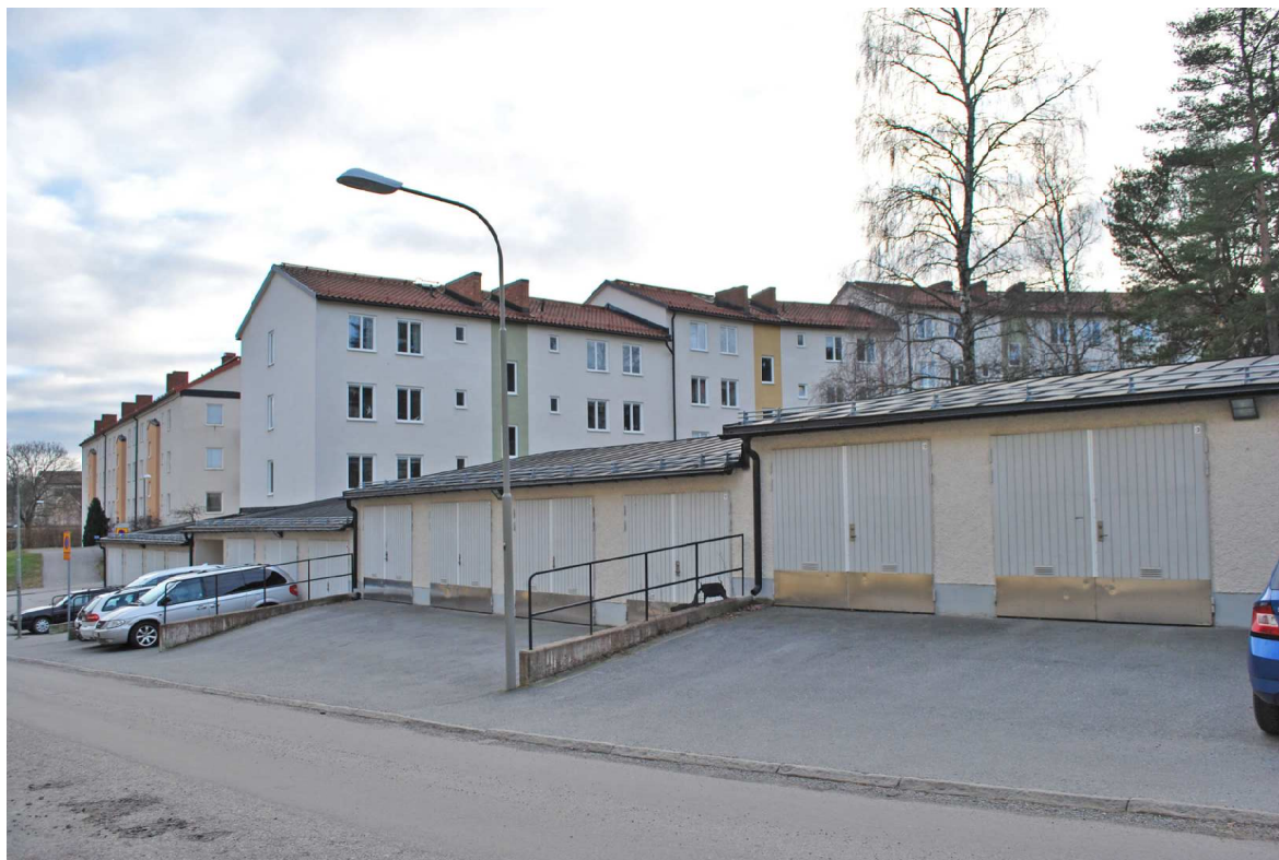
Garagelängan delas av med låga betongsargar och svarta stälkräcken. Träportarna är nya och har försetts med modern beläggning, sparkplåtar och brytskydd.
