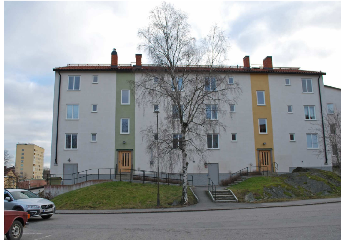
Efter fasadrenovering. Foto: Tyréns, 2020.
