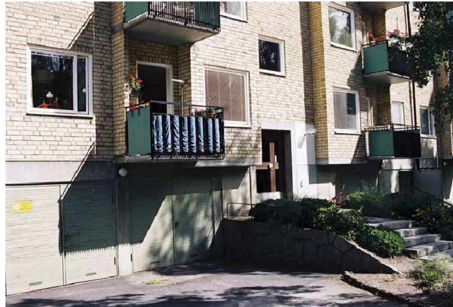
Parkeringsgarage integrerat i lamellhusets souterrängvåning med portar förlagda till långsidan. Portar i liggande träpanel, sannolikt ursprungliga från 1950-talet. Holbergsgatan i Blackeberg. Foto: Stadsmuseet via Bebyggelseregistret.
