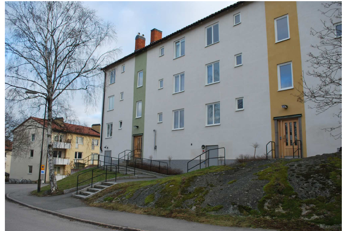
I väster är bostadsentréer förlagda mot gatan. Den kuperade förgårdsmarken överbyggs med hjälp av trappor i granit flankerade av smidesräcken.
