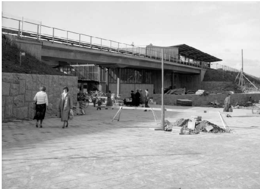
Tunnelbanestationen under byggnation, 1954. Stockholmskällan
