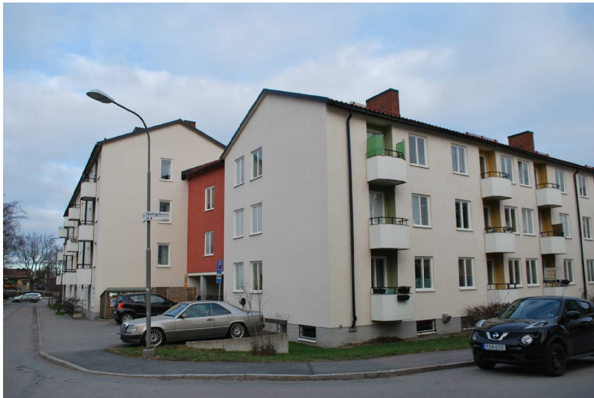
Husen är sammanlänkade i hörnen genom en förbindelse i två våningar. Den på pelare upphöjda föbindel-selänken bildar en entré till gården söderifrån.
