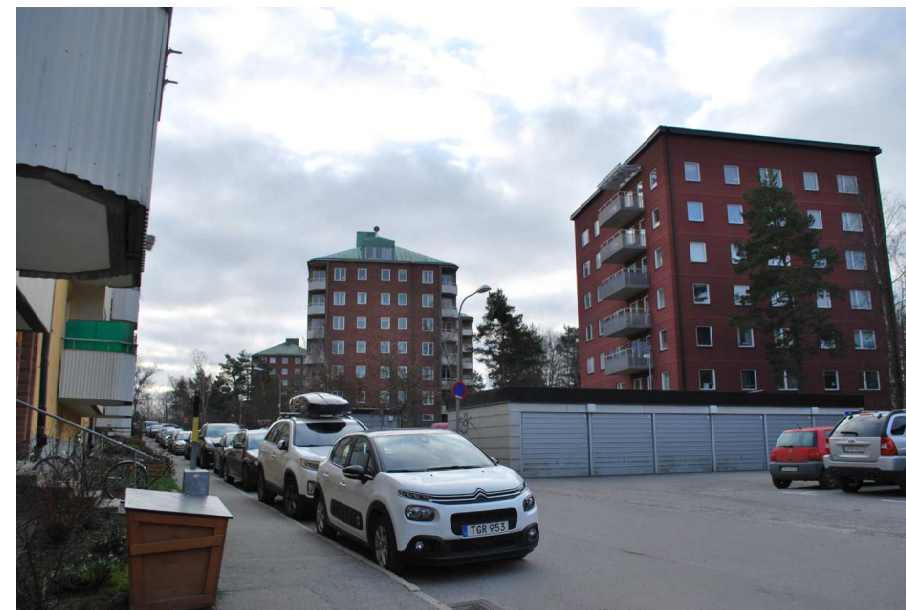
Sentida punkthus vid Fågelstavägen. Punkthuset är placerat i sluttningen, mellan de tegelklädda 1950-talspunkthusen på höjden och lamellhusen i väster.
