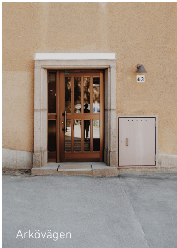
Entré i fasadliv med sten-omfattning
