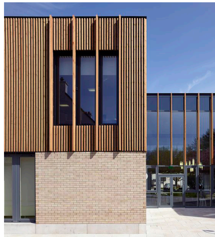
Lätt trästruktur på en sockelvåning i tegel
