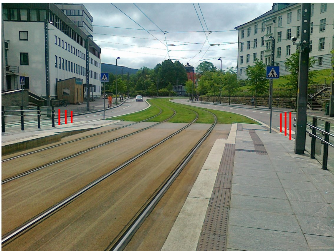
Figur 19 De röda strecken illustrerar att tidigare staket i plattformens bakkant löpt hela vägen fram till övergångsstället. Trafikanter hade svårt att se barn som stod och väntade vid dessa passager, så staketet i bakkant på plattformen förkortades för att barn tydligare skulle synas i trafikmiljön.
