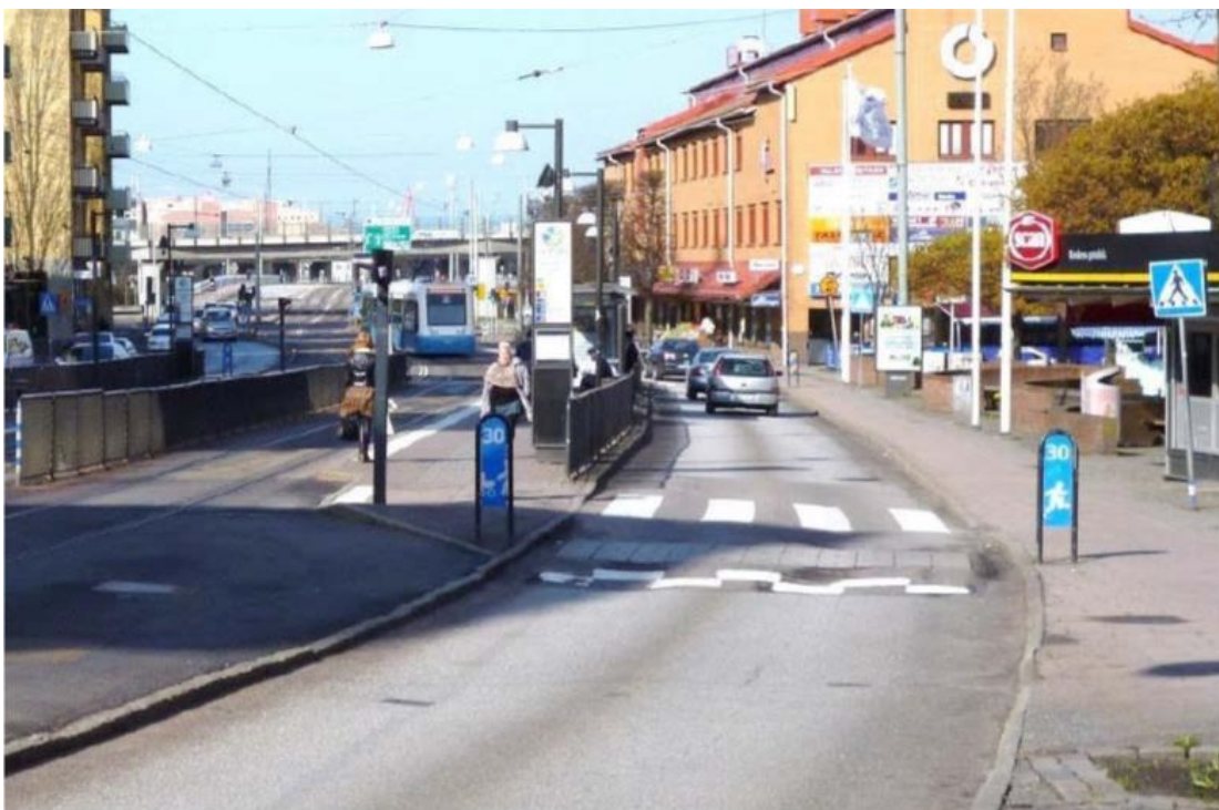
Figur 14 visar spår i gatumiljö i reserverat utrymme där ljussignal och kontrastmarkeringar hjälper till att uppmärksamma resenärer på de olika trafikslagen. Foto: Robert Olofsson.
