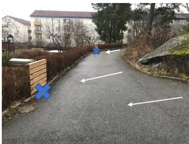
Figur 21. Betongrännorna markerad med blått kryss.
