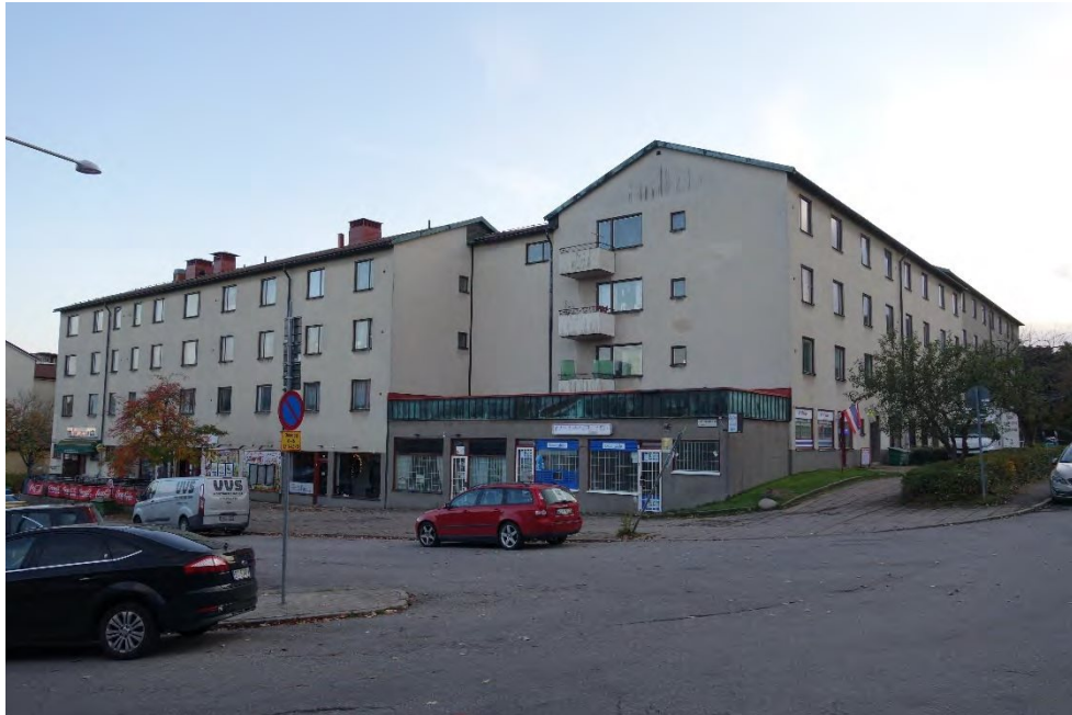
Vy från Lysviksgatan och norr, med kvarteret Grönsö bakom kameran. Här ligger en envånings butiksbyggnad, vars tillkomst möjliggjordes genom en stadsplaneändring redan innan fastigheten bebyggdes. (Läs mer om detta tidigare i handlingen).
