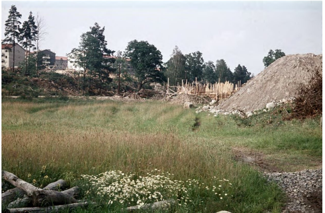
Vy från plats där högt flerbostadshus, Larsbodavägen 59 skall byggas. Gamla Farstavägen syns i bakgrunden. I fonden flerbostadshus vid Lysviksgatan. Diabilden är tagen av Ann-Marie Lamm. Källa: Digitala stadsmuseet.
