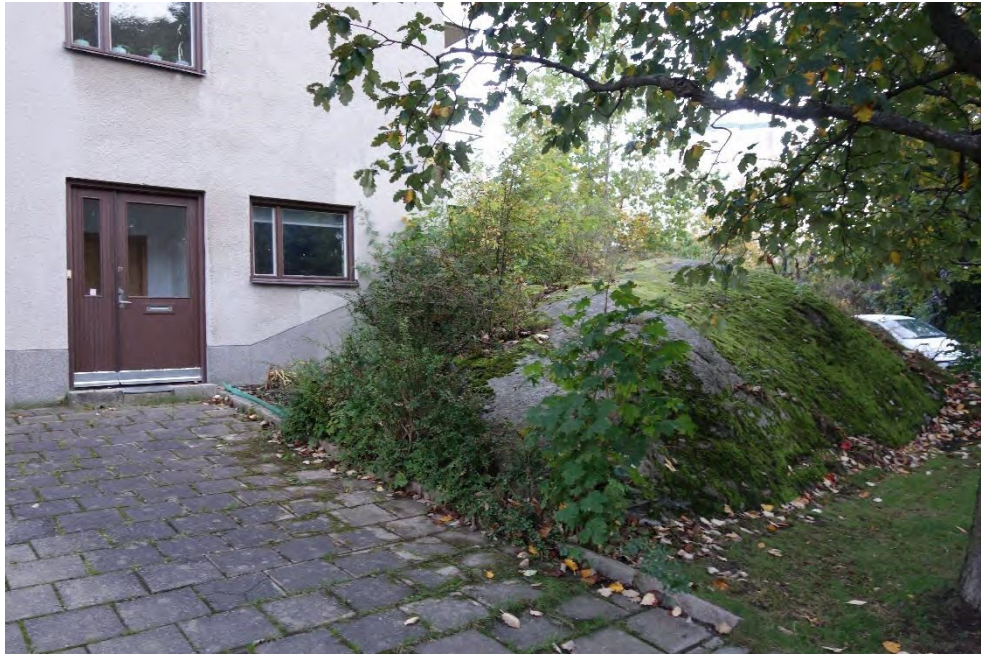
I fastighetens västra hörn bryter naturberget upp i dagen och byggnadskroppen ”klättrar” upp och vilar på bergsknallen.
