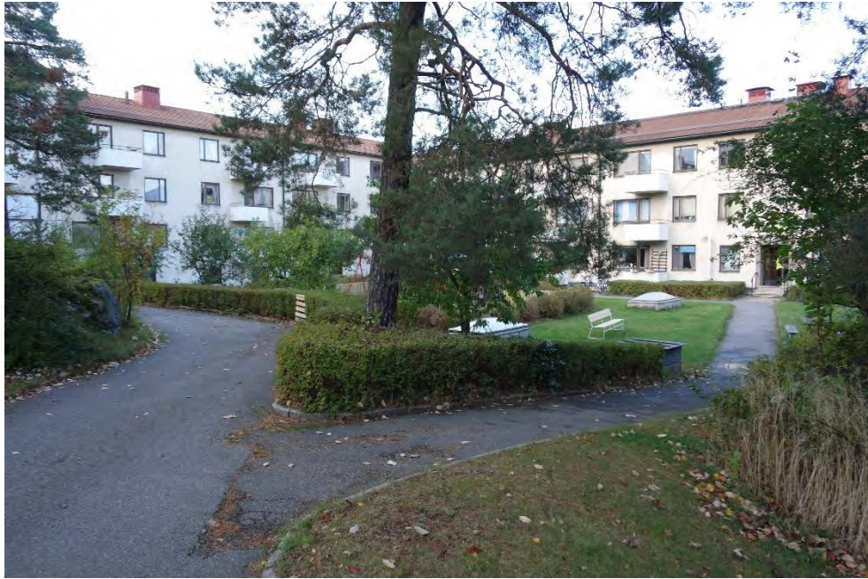
Vy in på innergården på Ledarö 3. Innergården består till hälften av lätt modulerad naturmark (mot sydväst) och till hälften av slät gräsmatta på betongbjälklag (mot nordost). Till vänster i bild anas naturberget och till höger i bild en av de överljuskupoler som för ner ljus till det underliggande garaget.
