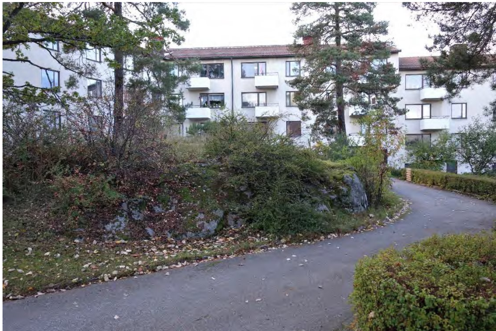
Vy mot den relativt stora bergsknalle som bryter igenom markytan på innergårdens sydvästra del. Kombinationen av stora innergårdar med naturmarkskaraktären och trevåniga flerbostadshus med en balkong per lägenhet är mycket karaktäristisk för det svenska 1950-talets flerbostadsområden.
