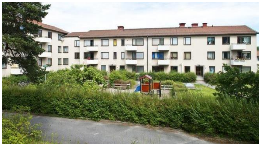
Vy över östra delen av gårdsrummet med lekplats och sociala ytor på underbyggt gårdsbjälklag. (Bild: Olov Lindgren AB)
