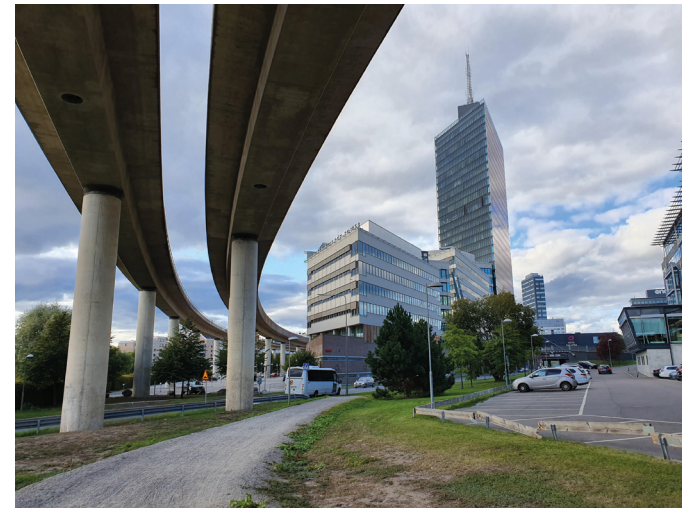
Tunnelbanebron utgör ett tydligt formelement i området.
