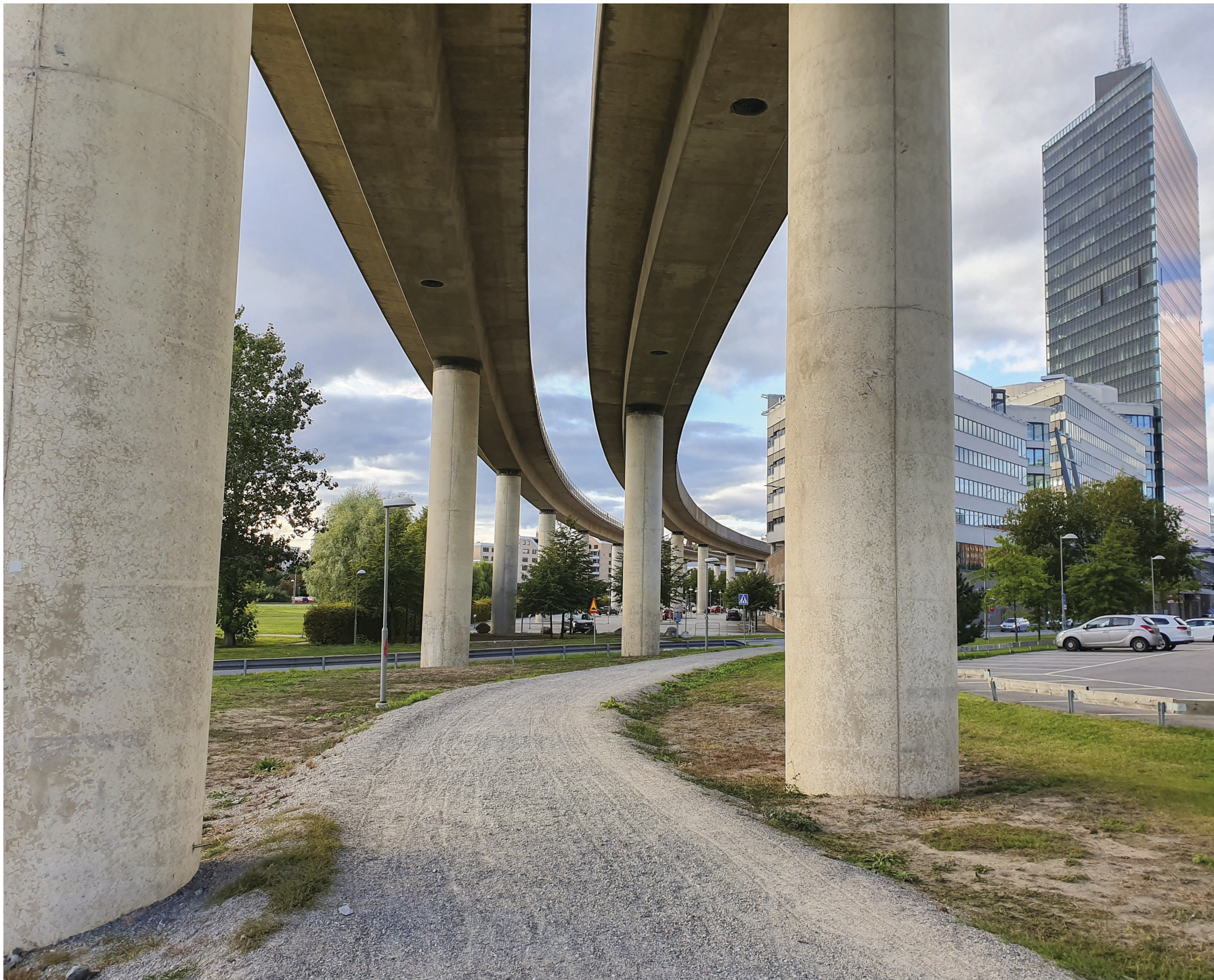
Tunnelbanan, invigd 1975, vars monumentalt utformade brokonstruktion är den längsta i Stockholms tunnelbanenät och är både i kraft av sin storlek och gestaltning ett av stadsbildens mest tongivande byggnadsverk.
