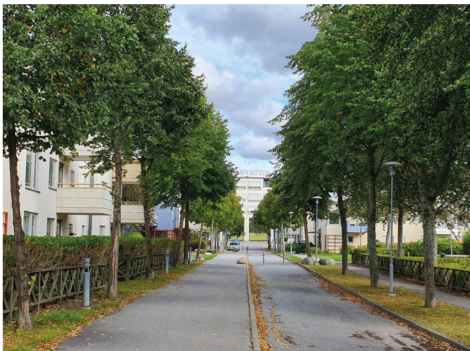
Koldinggatan med Kista fronts portalliknande huvudentré i fonden.
