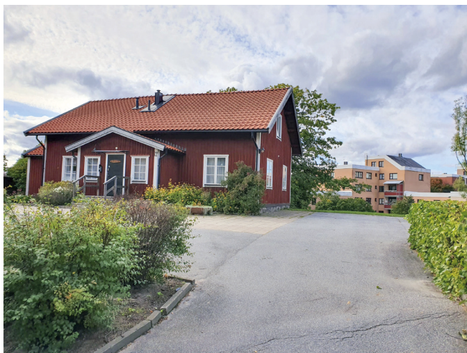
På Ärvinge gamla bytomt finns gårdens huvudbyggnad och en flygelbyggnad bevarade. De tjänar idag som föreningslokaler för bostadsrättsföreningen i kvarteret.
