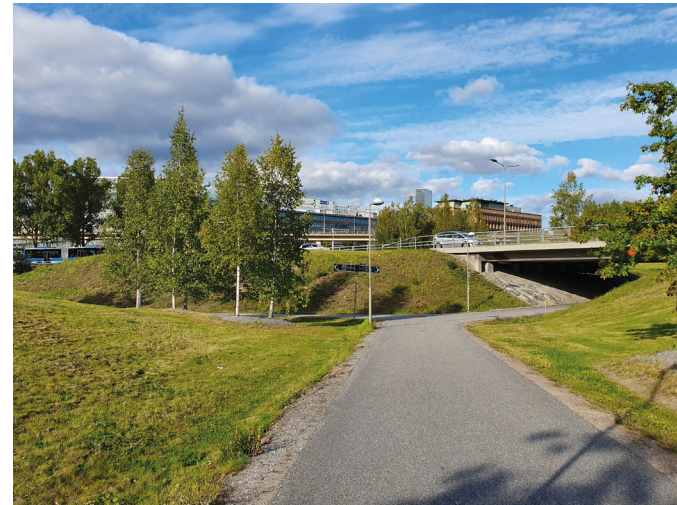
Genom det centrala gröonstråket löper ett förgrenat gång- och cykelvägnät som ger möjlighet att röra sig i skyddade passager under storskaliga transportleder.
