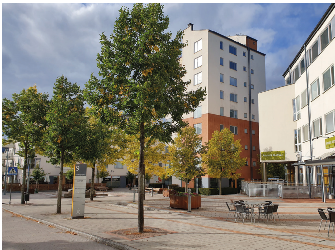
Koldinggatan utgör huvudentré till området och är direkt kopplad till kvarterets småskaliga torgbildning. Mot det vänder kontorshuset sina personalentréer med restauranger och andra serviceverksamheter i bottenvåningarna.
