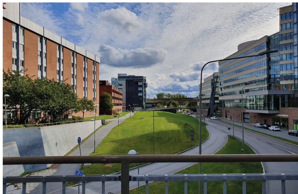
Kista centrumanläggning har förlagts på betongdäck över dalgången och bildar en länk mellan bostadskvarteren och arbetsplatsområdet.
