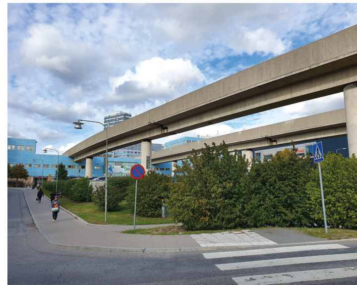
Tunnelbanan anlöper Kista torg på eleganta viadukter ritade av SL:s chefsarkitekt Michael Granit och landar ovanpå den ursprungliga centrumanläggningen.
