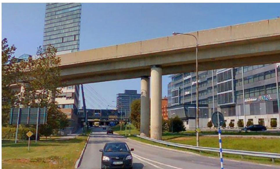
Figur 2.4. Foto över tunnelbanebron över Hanstavägen, sett söderifrån. Tvärbanan kommer passera strax vänster om vägbanan, och avståndet mellan spår och bropelare blir ca 10 meter.
