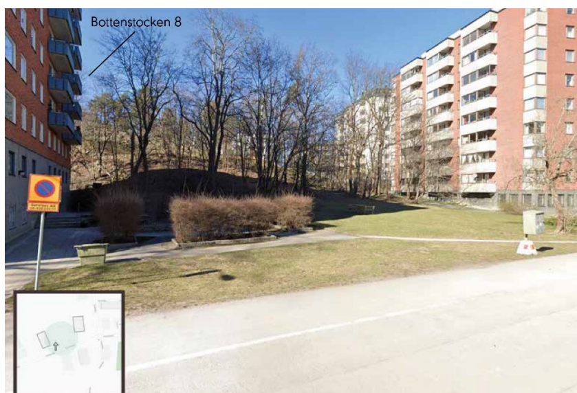
Platsen för nybebyggelse. Gröndalsvägen mot norr. Foto; Besqab, Bergkrantz
