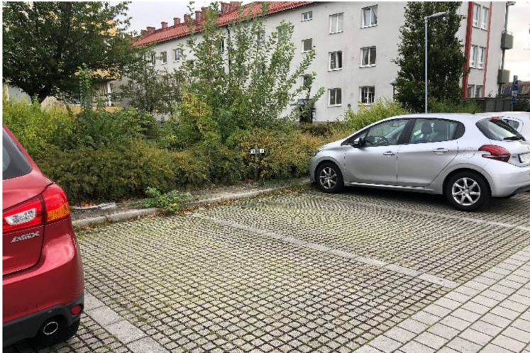
Figur 11. Exempel på genomsläpplig beläggning, gräsarmering (Foto: Bjerking AB).
