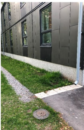
Figur 12. Exempel på makadamdike (t.v) och illustration genomsnitt av uppbyggnad (t.h) (Foto: Bjerking, Illustration: Bjerking AB).
