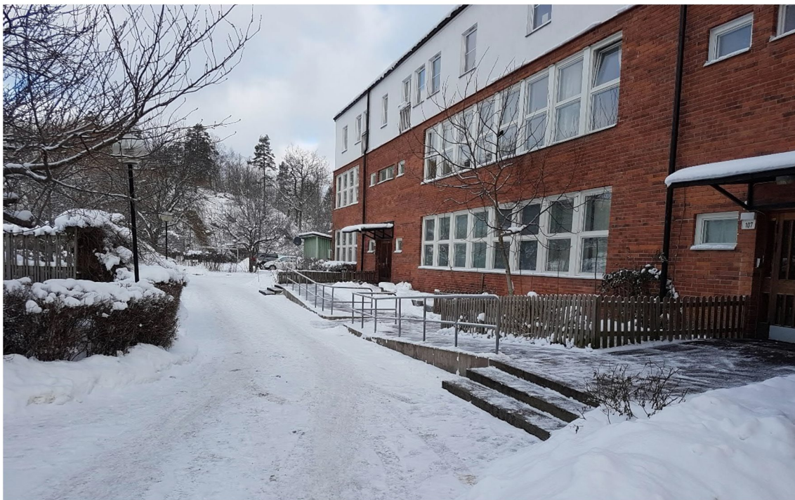
Foto 1. Ingångar till befintliga byggnader som kommer kvarstå är upphöjda, liten risk att vatten kan tränga in i byggnader.
