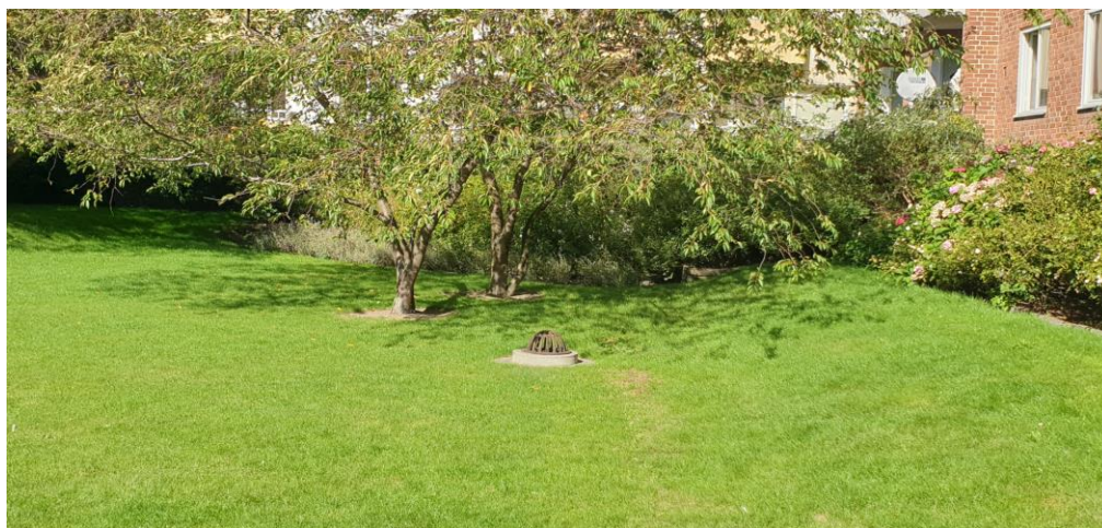
Figur 21 Stor nedsänkt innergård i Augustenborg, Malmö, som kan ta emot stora volymer dag- och skyfallsvatten. Ett upphöjt bräddavlopp ser till att mindre regn infiltrerar utan att nå dagvattenledningarna
