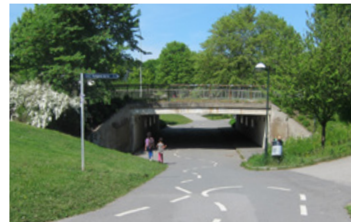
Figur 6. Gångtunnel under Vårbergsvägen.
